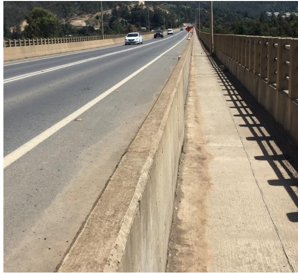
Ilustración 4-26: Sensores instalados a lo largo de la berma del puente CRSH.
