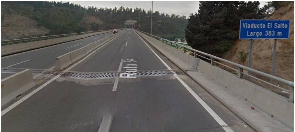
Ilustración 3-2: Fotografía viaducto El Salto Largo(Google Maps, 2019).
