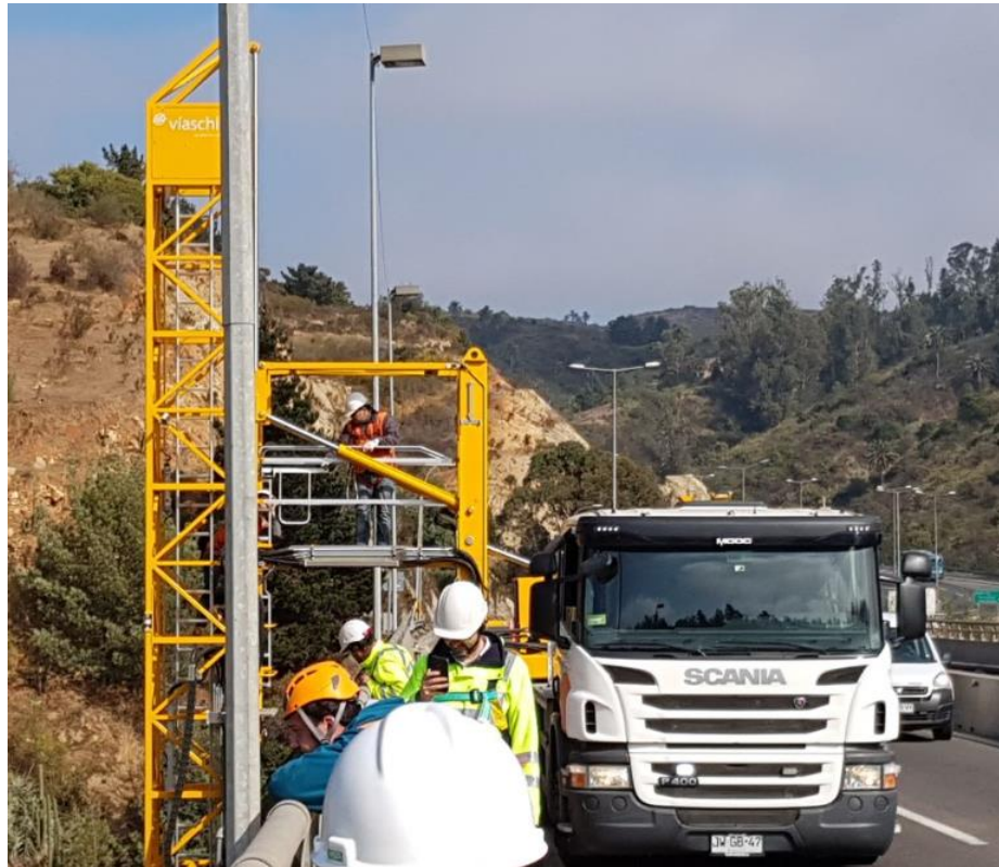
Ilustración 3-10: Camión inspector utilizado para la instalación de instrumentos en las cepas.
