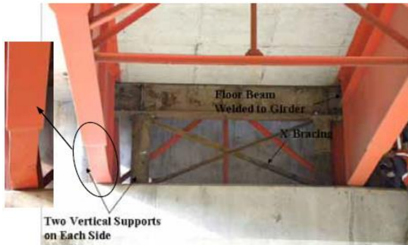
Ilustración 4-16: Fotografía de la reparación temporal en el estribo noreste del puente CRSH.
