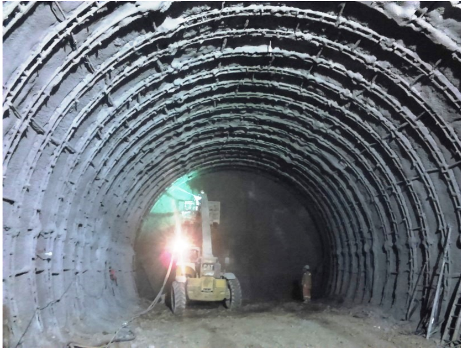
Figura 2-4: Fotografía Ejecución Sostenimiento de Túnel Interestación tipo Herradura
