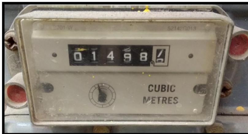
Figura 48: Medidor de gas instalado en las cañerías de gas
