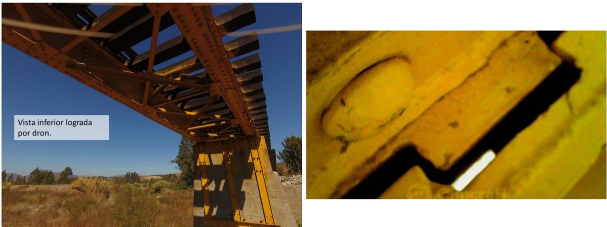
Figura 5.25: Imágenes logradas durante la inspección; A la izquierda imagen obtenida por el dron, a la derecha imagen obtenida por el brazo desplegable.
