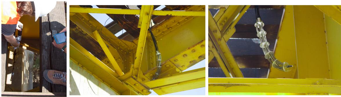
Figura 5.19: Manipulación desde arriba del puente; se aprecia en la primera fotografía el modo de uso de los operarios, uno controla el brazo y otro visualiza las imágenes en el celular. En las dos fotografías siguientes, como el brazo logra de manera exitosa alcanzar lugares de difícil acceso.
