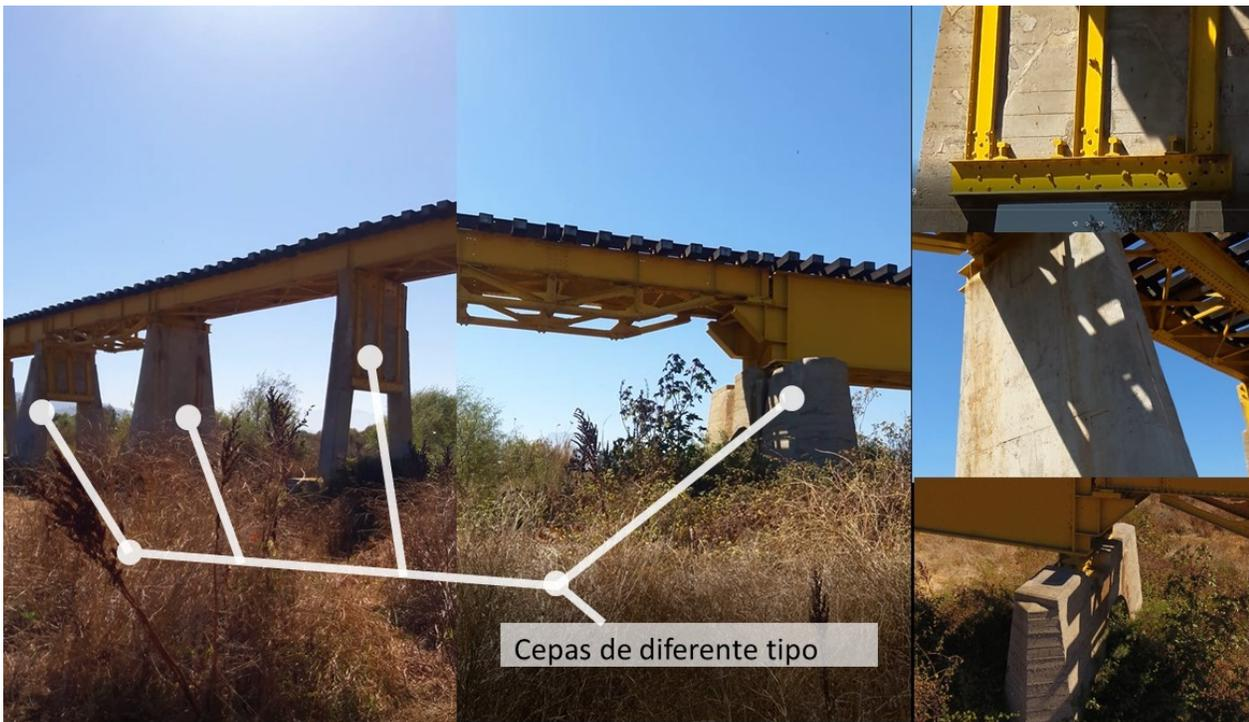
Figura 1.5: El Puente presenta diferentes configuraciones. Existen diversos tipos de cepa que dan sustento a la estructura. Derecha; ejemplos de cepas.
