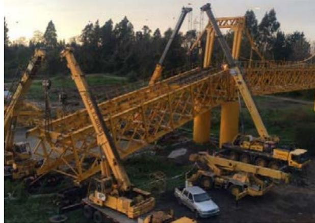
Figura 1.1: Colapso de puente ferroviario sobre Río Toltén [8]
