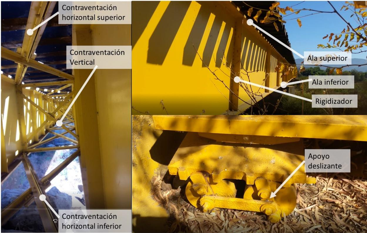
Figura 1.4: Izquierda; contravenciones existentes en la configuración sur. Derecha; componentes de viga del sector sur y apoyo deslizante del estribo sur
