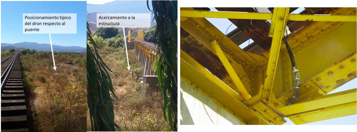
Figura 5.24: Distancia típica lograda respecto a la estructura durante la inspección; A la izquierda el posicionamiento del dron respecto al puente, a la derecha el posicionamiento del brazo desplegable.
