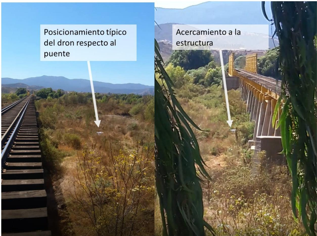
Figura 1.6: Izquierda; distancia típica del dron respecto a la estructura durante la inspección. Derecha; dron mientras emprende su vuelo bajo un vano
