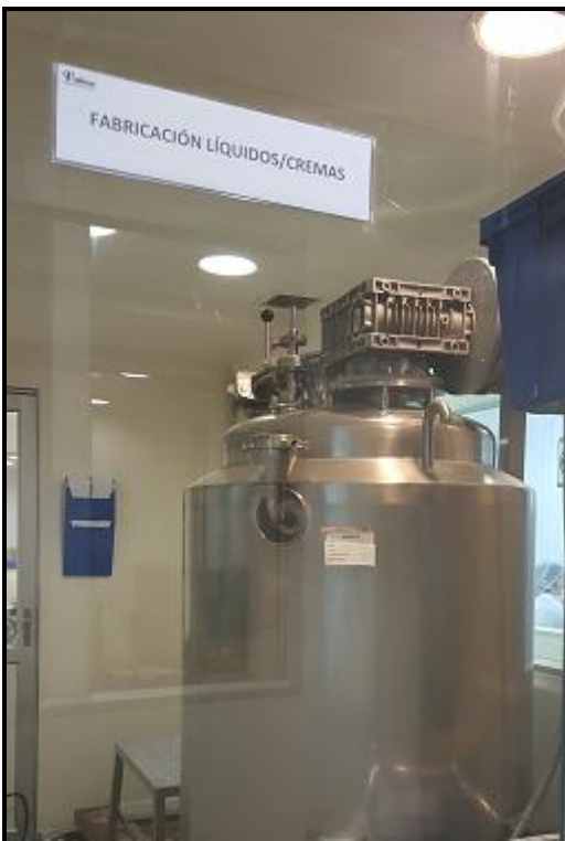
Figura 12: Sala de fabricación de líquidos y semisólidos
