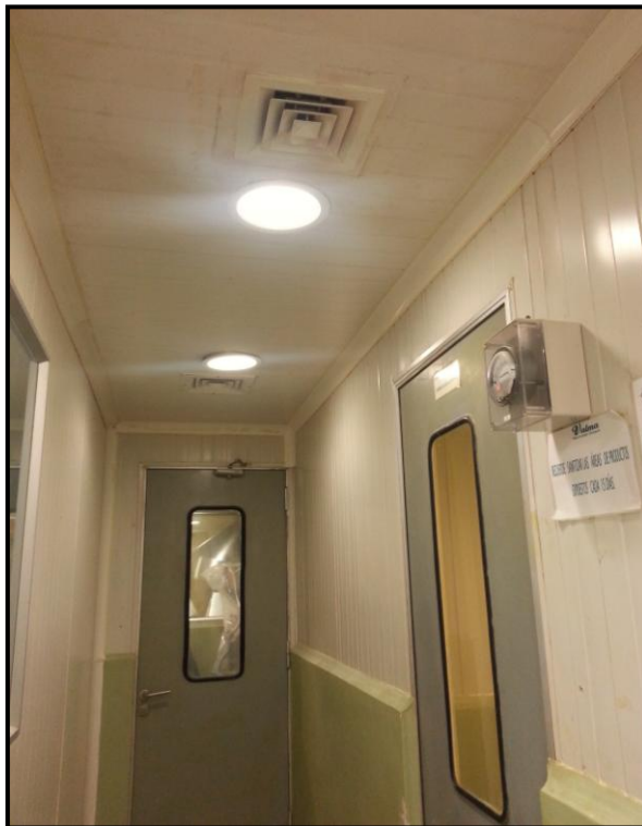
Figura 4: Imagen de puertas del área de líquidos
