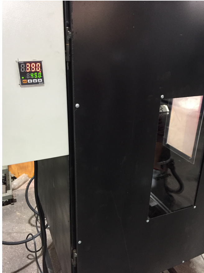
Figura 9.5: Prueba sistema completo. Fuente: Elaboración propia
