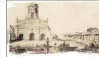
Construcción de la torre del Templo de la Recoleta Franciscana. Año 1848.
