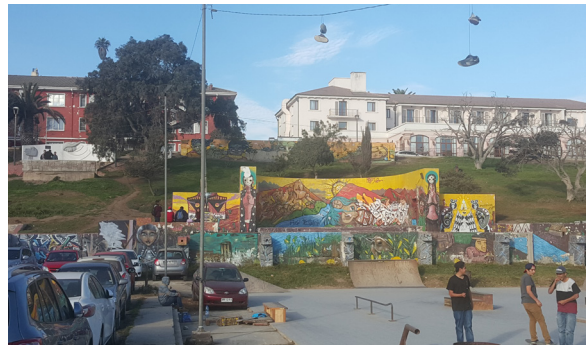
Espejo de Agua deteriorado. Fuente: Elaboración propia.
