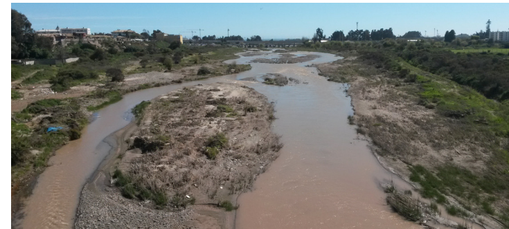
Río Elqui deteriorado vista Puente Libertador.
