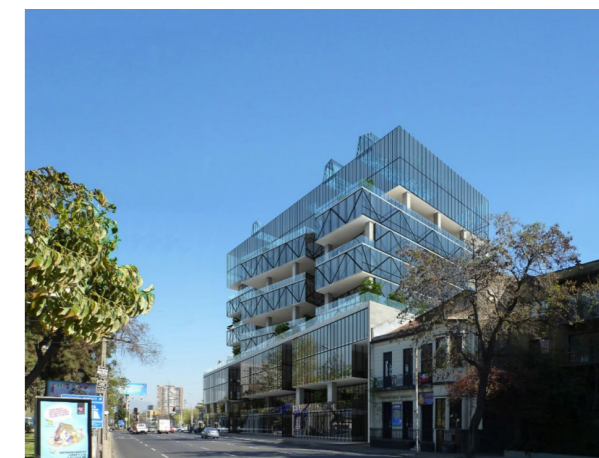
Núcleo Tecnológico Bellavista. Fuente: Sabbagh Arquitectos
