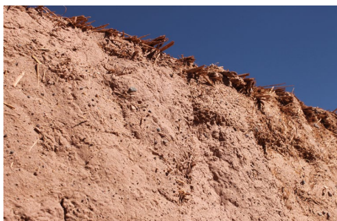
Imagen Muro réplica vivienda Aldea de Tular. Fuente: Elaboración propia.
