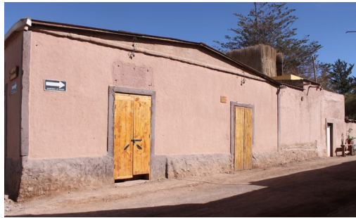
Imágenes arquitectura colonial en San Pedro de Atacama. Fuente: Elaboración propia.
