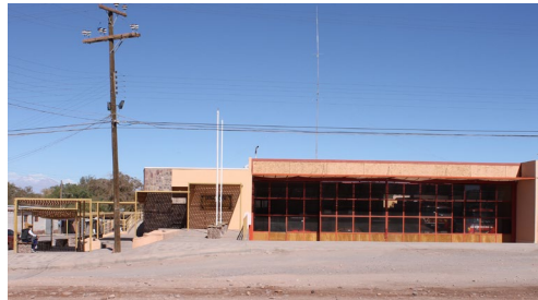
Imagen Estación de Bomberos San Pedro de Atacama. Fuente: Elaboración propia.
