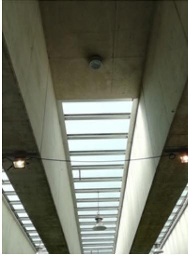
**IMAGEN 69** Vista de Lucarnas, línea de focos removibles, lámpara colgante y lámpara embutida sobre pasillo galería
