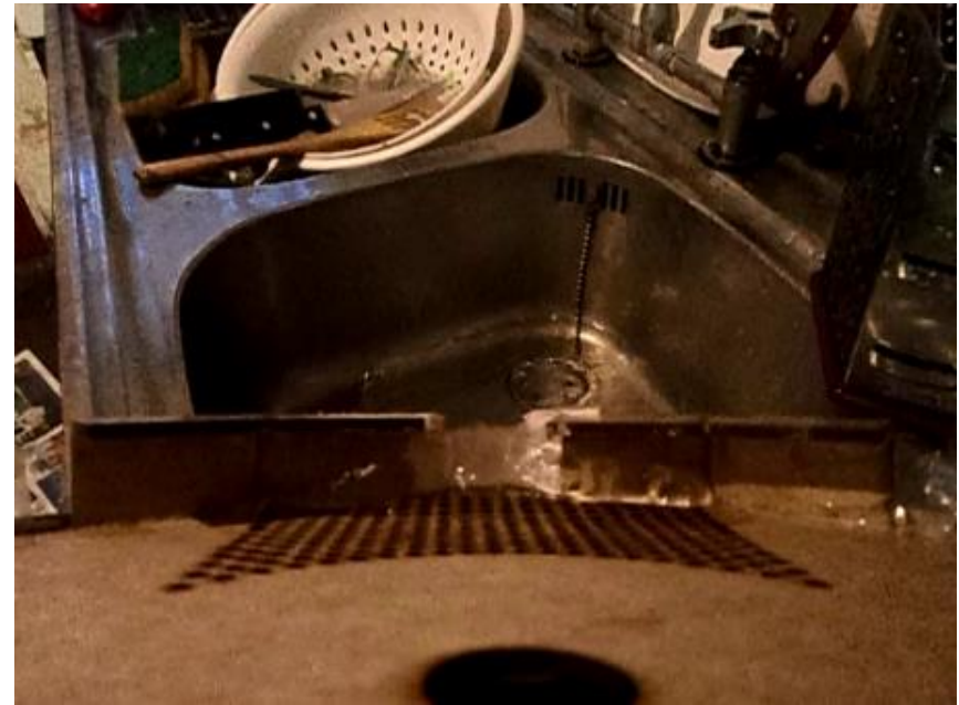
Canalización del agua labios 10 cm.
