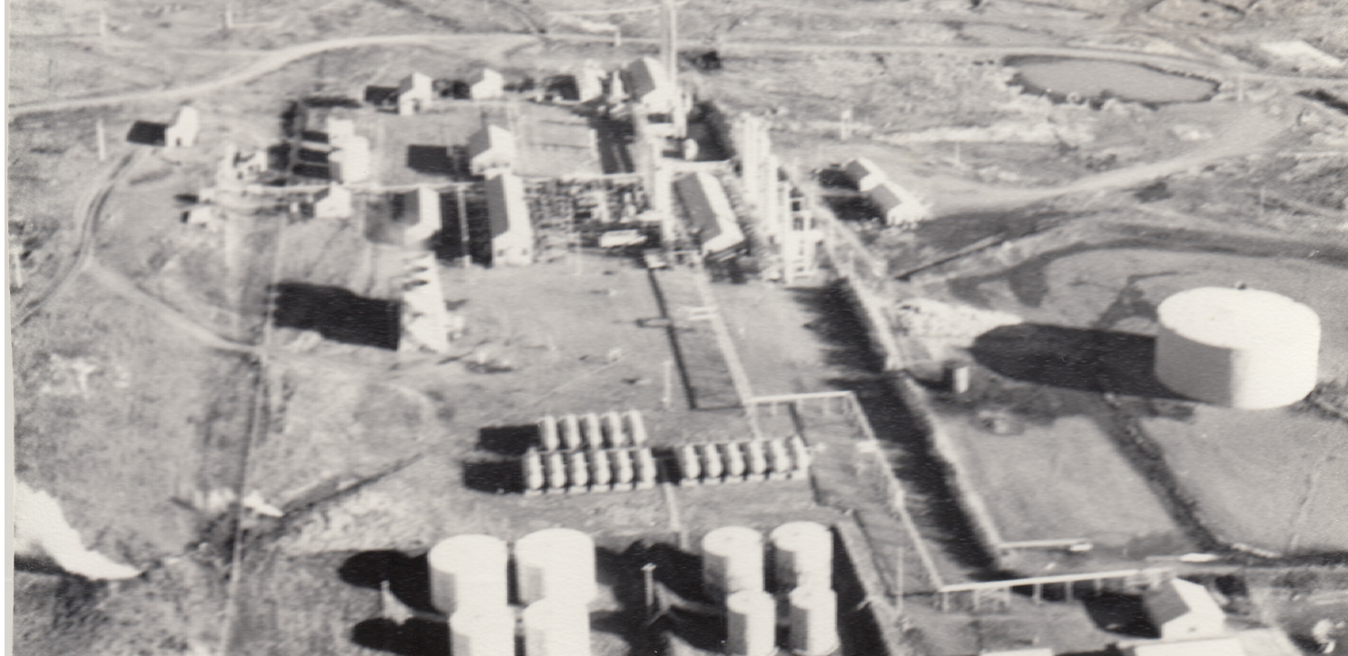
Fig. 49: Gallardo, P (1972): " Vista 1: Aérea de la planta Manantiales" Fuente: Bayot, N
