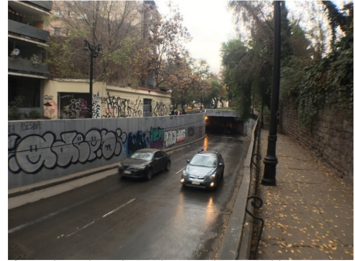
Imagen 17, foto vereda costado paso bajo nivel Victoria Subercasseaux, elaboración propia
