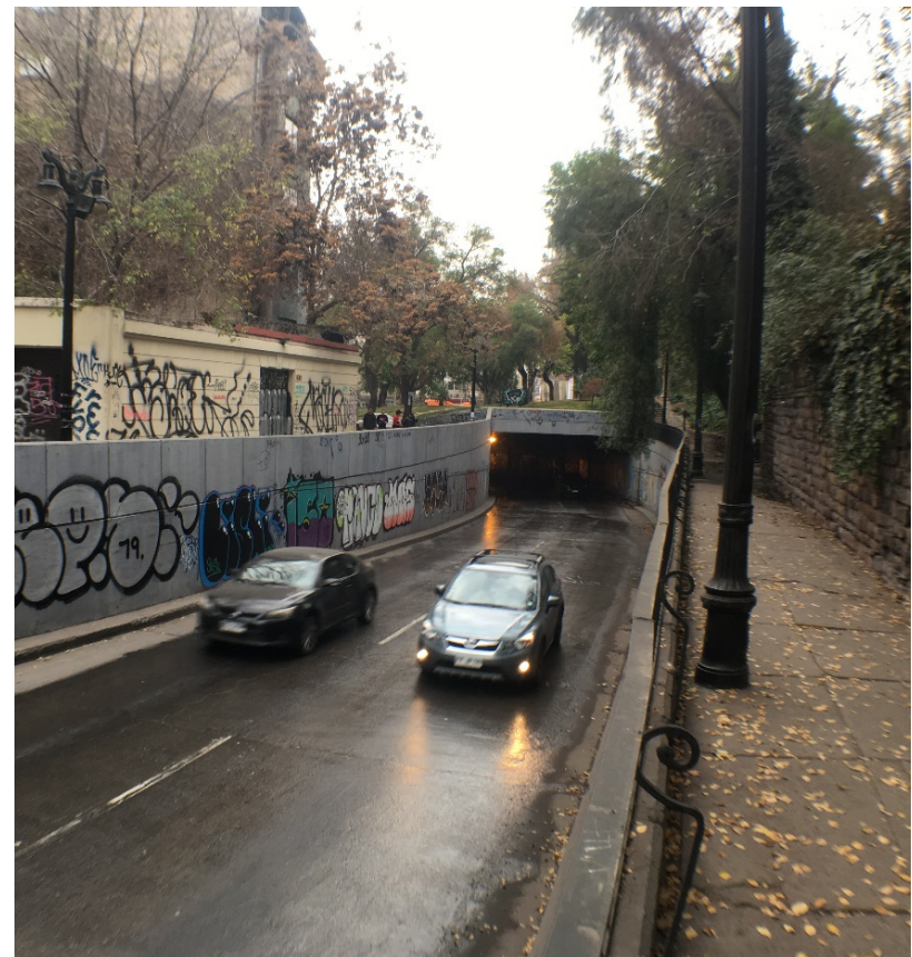
Imagen 51, foto paso bajo nivel Victoria Subercaseux, elaboración propia
