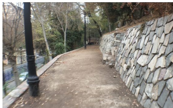
Imagen 13, foto muro contención inferior, elaboración propia
