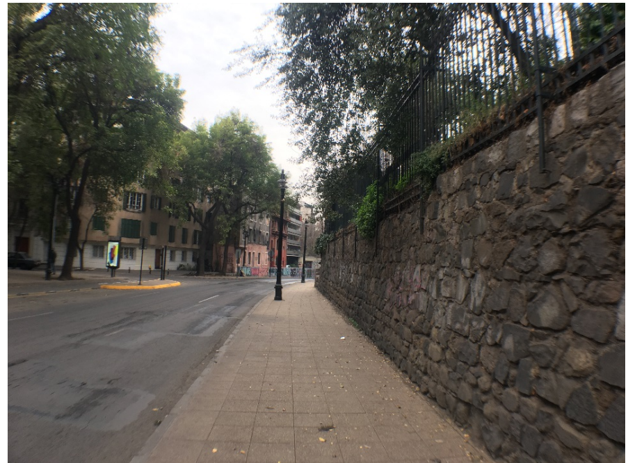
Situación 2 vereda entre muro de contención y calle
