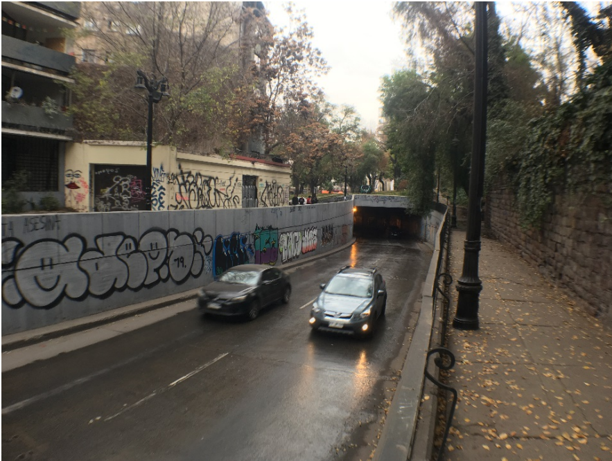
Situación 1 vereda entre muro de contención y desnivel vehicular
