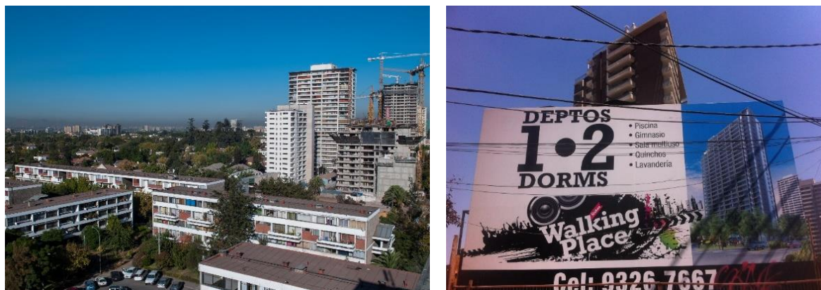
Ilustración 125: Izquierda: Vista desde torre de 10 pisos hacia el oriente. Derecha: paleta publicitaria de proyecto inmobiliario junto a Villa Frei, aparecido el año 2016, posterior al año de la declaratoria de Zona Típica. Fuente: Elaboración propia.
