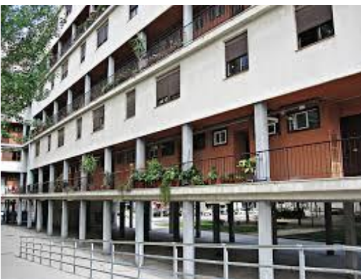
Ilustración 38: Imágenes de Casa Bloc, que muestran como el bloque genera dos patios centrales semipúblicos, mediante el levantamiento de los bloques residenciales: Fuente: www.plataformarquitectura.cl
