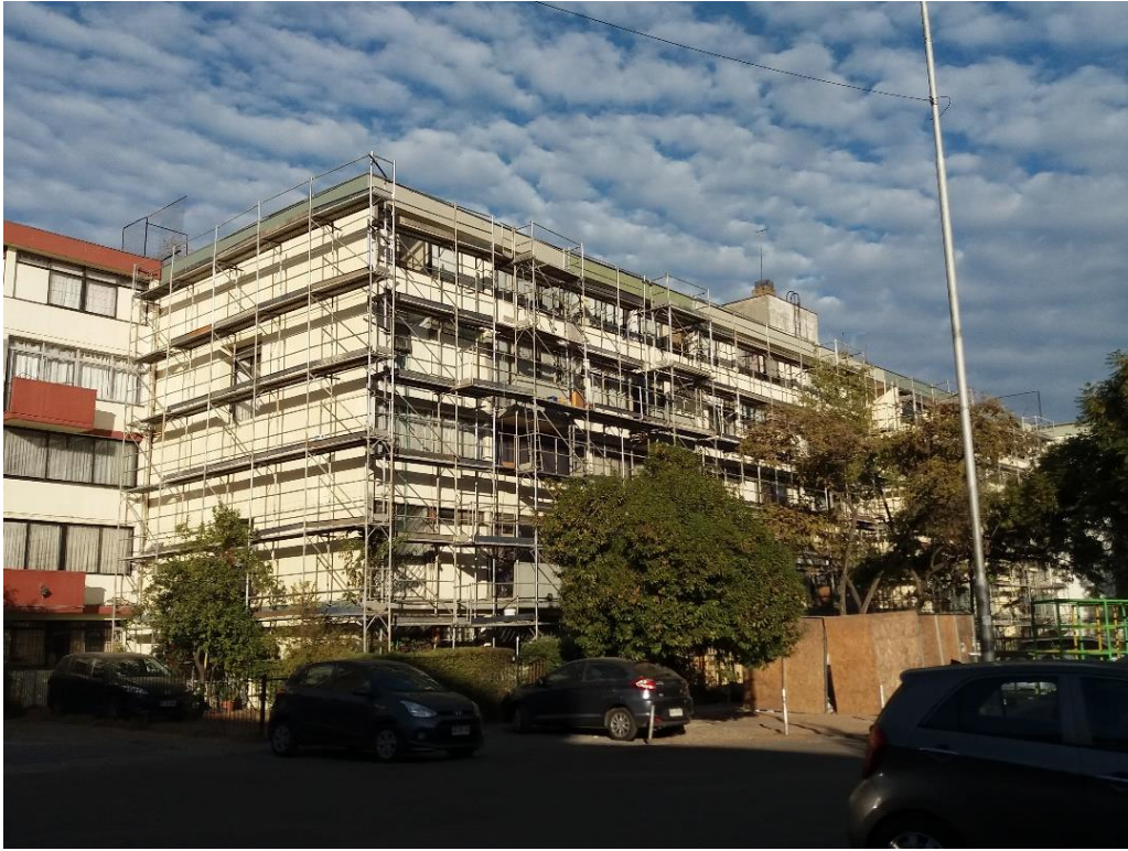
Ilustración 131: Obras de reparaciones en bloque 33, Villa Olímpica. Programa de Mejoramiento de Condominios Sociales (MINVU)
