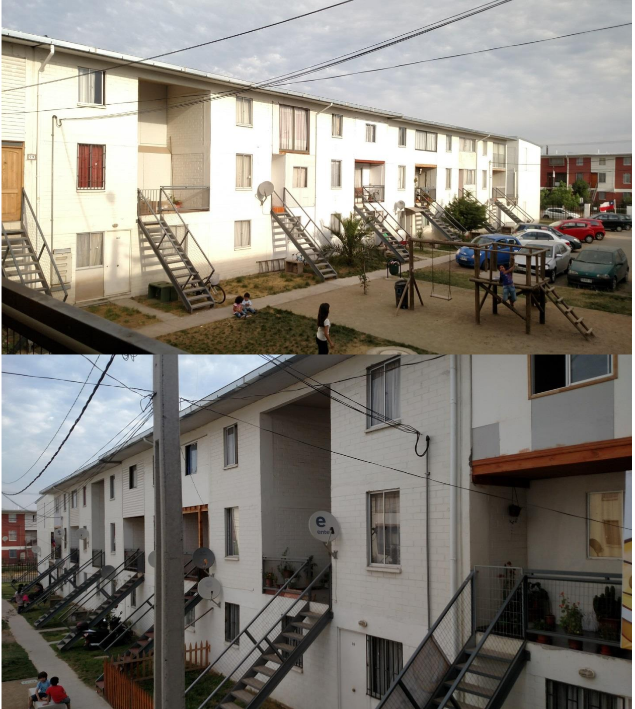
Fig. 15-16 Fachadas de viviendas con escalera exteriores de acceso. Fuente: Elaboración propia.
