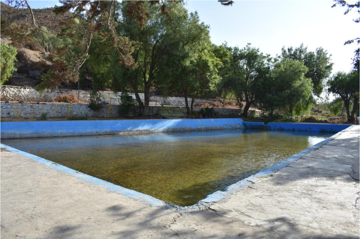
Fotografía 2: Tranque Hierro Viejo, refaccionado por INDAP. Fuente: Registro propio.
