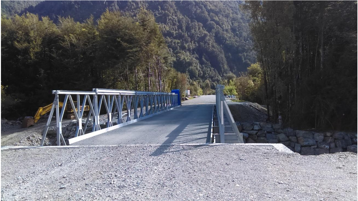
Figura 30. Construcciones del Cuerpo Militar del Trabajo, Vodudahue. Fuente: Proyecto Fondecyt N.º 1151087.
