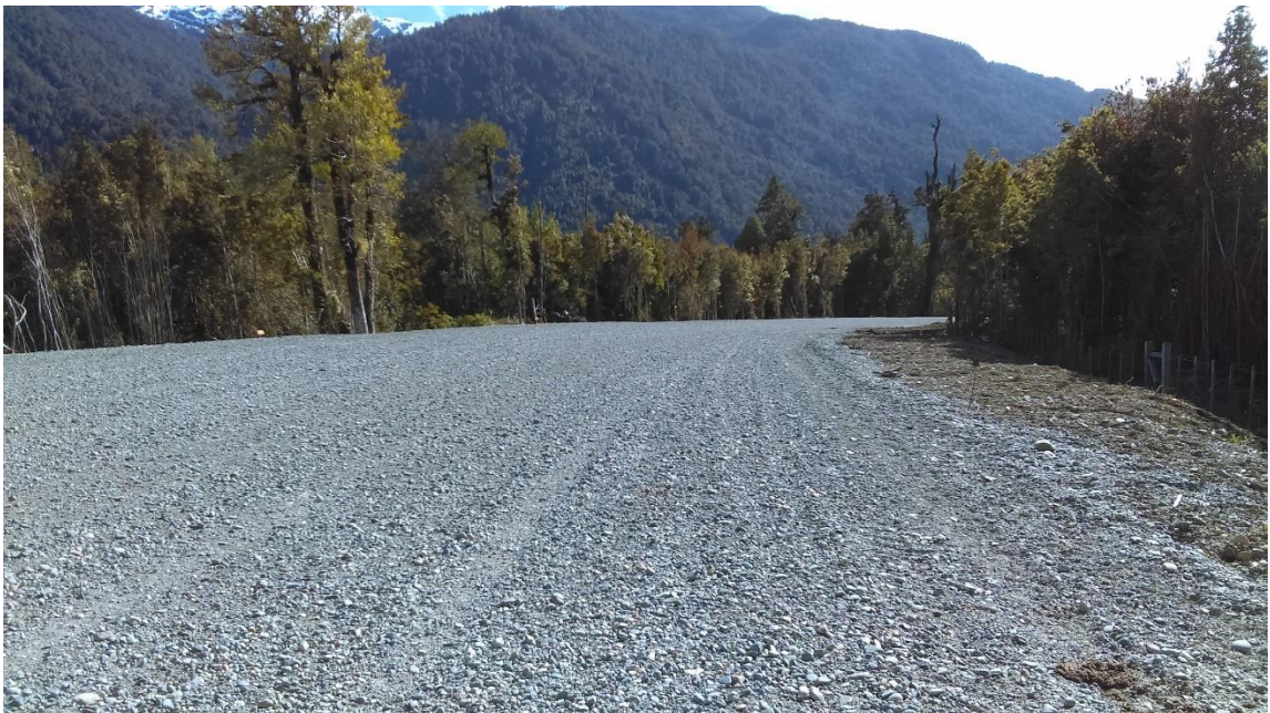
Figura 32. Trabajos del Cuerpo Militar del Trabajo, Vodudahue. Fuente: Proyecto Fondecyt N.º 1151087.
