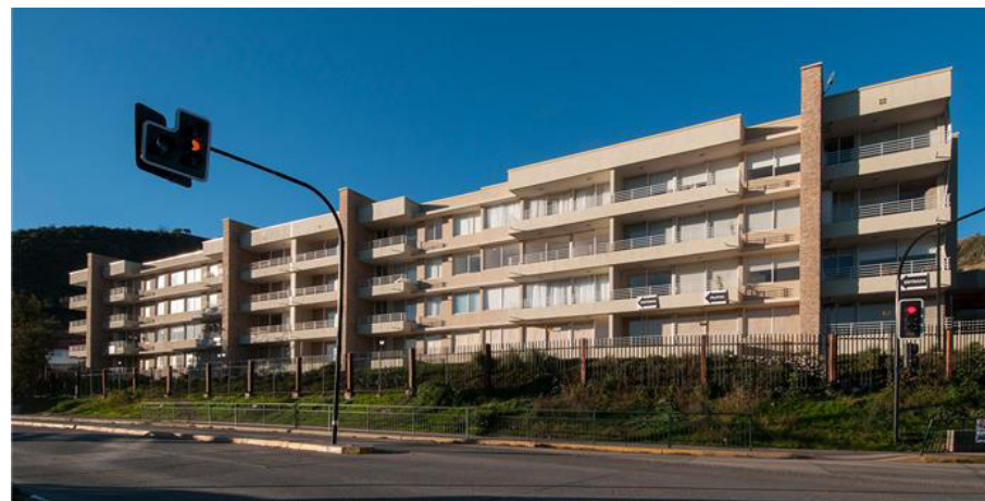
Figura 11. Imagen referencial Condominio La Viñita Inmobiliaria Solari Fuente: http://solari.cl/proyecto/condominio-la-vinita-2/
