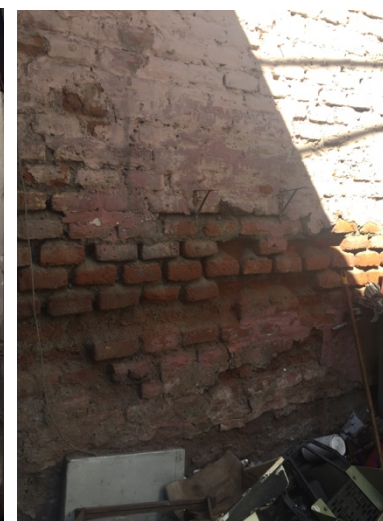
Muro medianero posterior con daños por erosión de material Fotografía de la autora, 2017.
