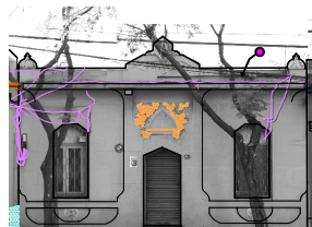
Fachada actual (ver lev. crítico)
