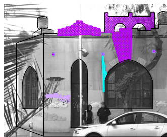
Fachada situación al 01.06.2017
