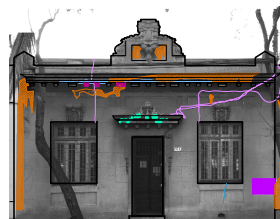
Fachada actual (ver lev. crítico)
