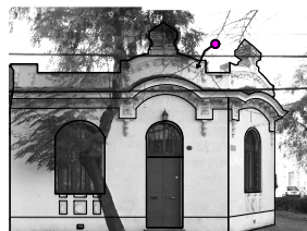
Fachada actual (ver lev. crítico)
