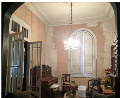
Muro de fachada interior relleno con yeso – Madrid 962 Fotografía de la autora, 2017.
