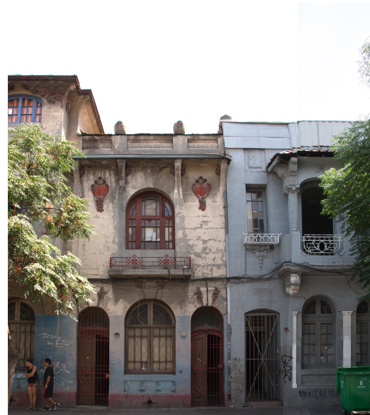
Inmuebles del conjunto hacia calle Catedral Fuente: fotografía de la autora, 2019
