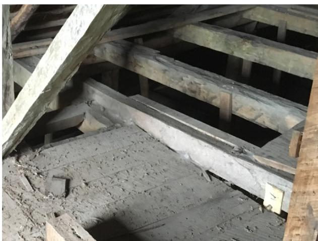
Se aprecia corte y caída de la primera viga, a la cual se adhiere un par de suples.
