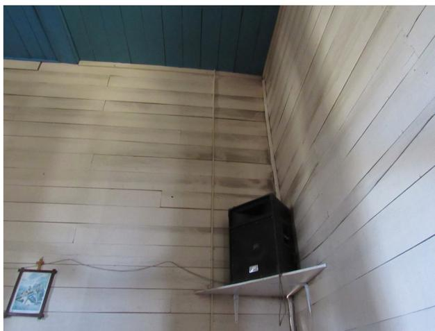
Depósitos de suciedad en revestimiento interior de tabiques
