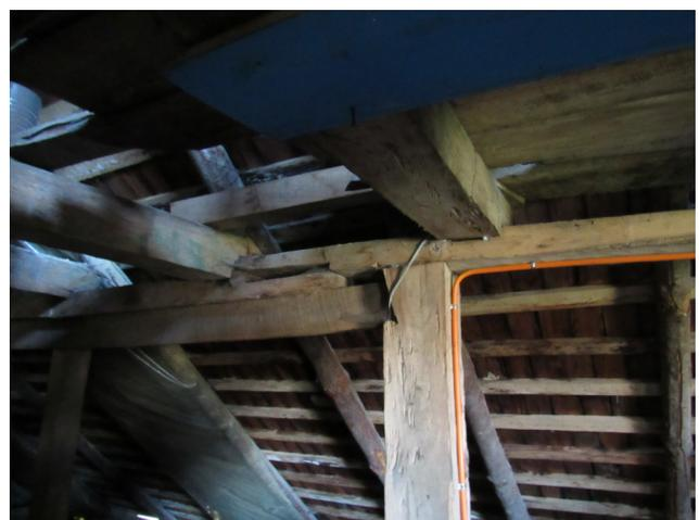
Separación del empalme de media madera en solera superior, correspondiente al lado derecho.
