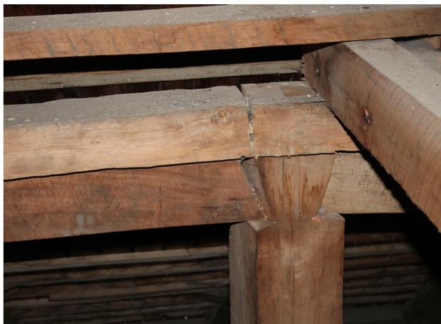
Detalle intervención en pilar, para sujetar travesaño. Aparenta ser una Cola de Milano. Además, se ve corte en solera superior
