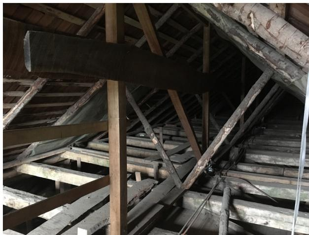
Cantonera a lo largo de todo el eje a altura media. Apparently quedó de la faena, porque no tiene función estructural.
