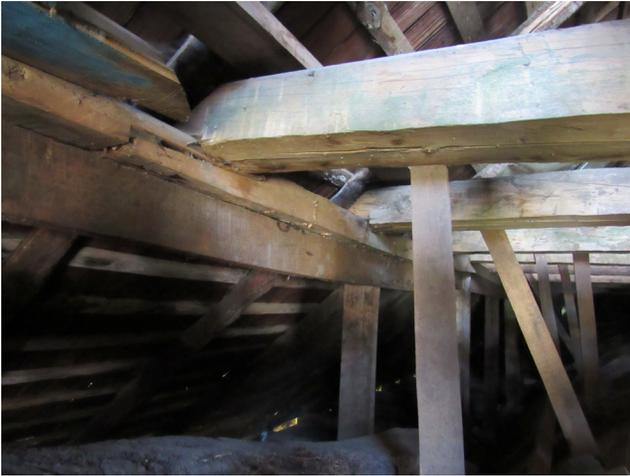
Separación del empalme de media madera en solera superior, correspondiente al lado izquierdo.
