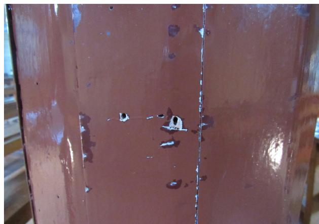
Erosión mecánica en fustes interiores
