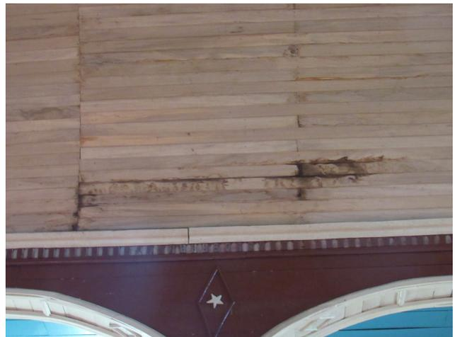
Revestimiento de tepa con manchas y pudrición debido a goteras.
