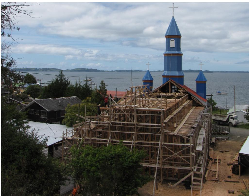
Intervención del área de las naves en iglesia de Tenaún. Segunda etapa de la Fundación. Se desarma todo y luego se rearma, reemplazando toda la estructura. Fotografía del autor.
