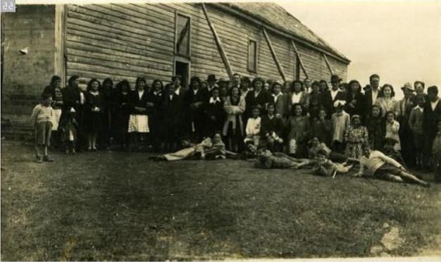
Fotografía con fecha desconocida, probablemente de las primeras décadas del siglo XX. Se puede observar la inexistencia de las ventanas de sacristía, y que el forro original era un tingle horizontal sin pintar, el cual permanece aún bajo las tejas.
