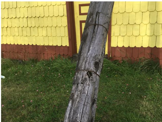
Reparación de puntal mediante empalme tradicional a media madera.
