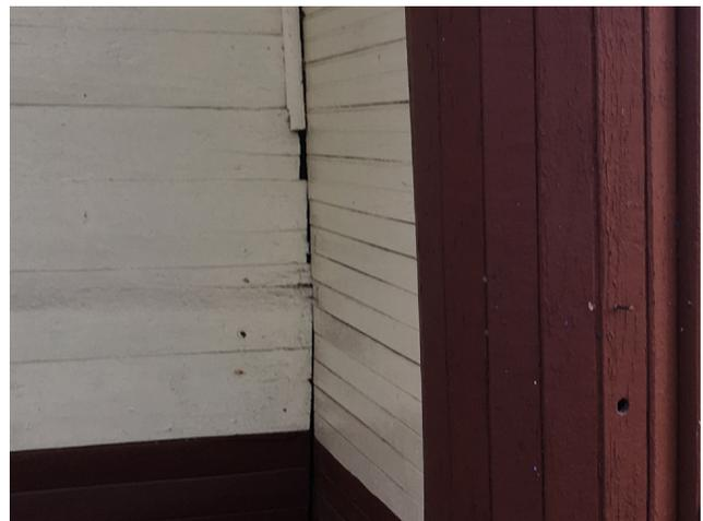
Desprendimiento de terminaciones y rajaduras debido a varios factores: deformaciones de la estructura y erosión mecánica.
