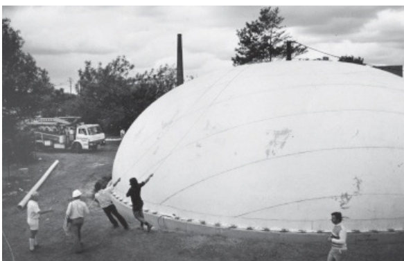
41. Molde inflable para cúpula en hormigón, Dante Bini, años '70 41. Pressostruttura per cúpula in calcestruzzo, Dante Bini, anni '70
