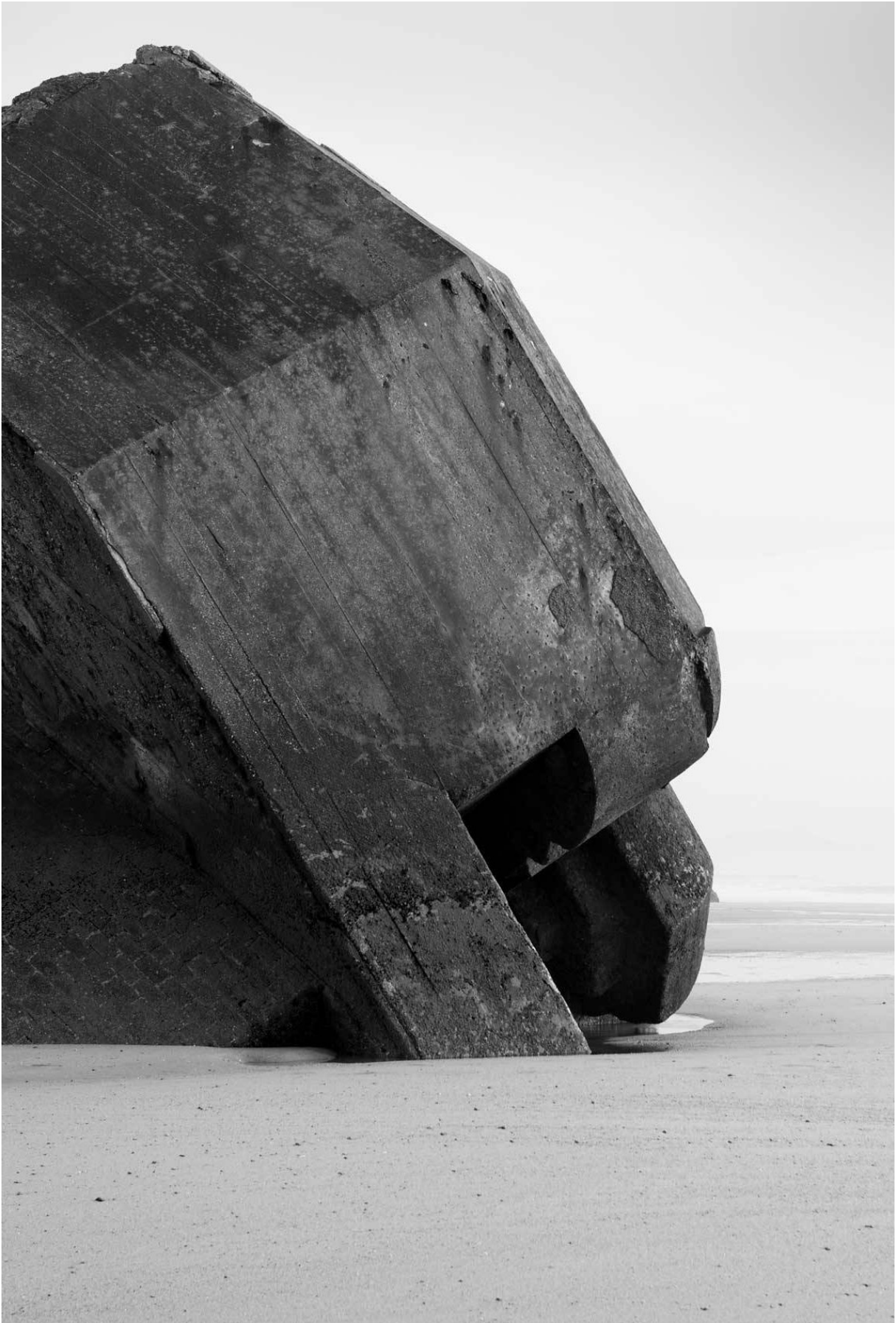
25. Los restos de un bunker alemano del Atlantikwall , Francia 25. I resti di un bunker tedesco dell' Atlantikwall , Francia
