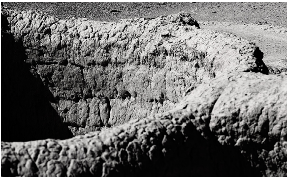
7. Particular de los adobones de los los recintos 7. Particolare dei blocchi in argilla cruda dei muri
