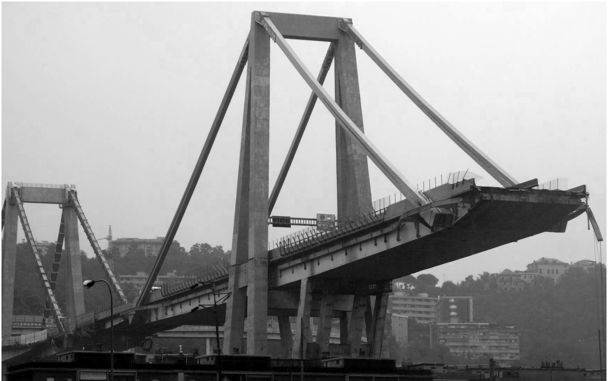
30. Viadotto Polcevera, Genova, Italia. Proyecto de Riccardo Morandi, 1963-1967. Colapsado el 14-8-2018 30. Viadotto Polcevera, Genova, Italia. Progetto di Riccardo Morandi, 1963-1967. Crollato il 14-8-2018
