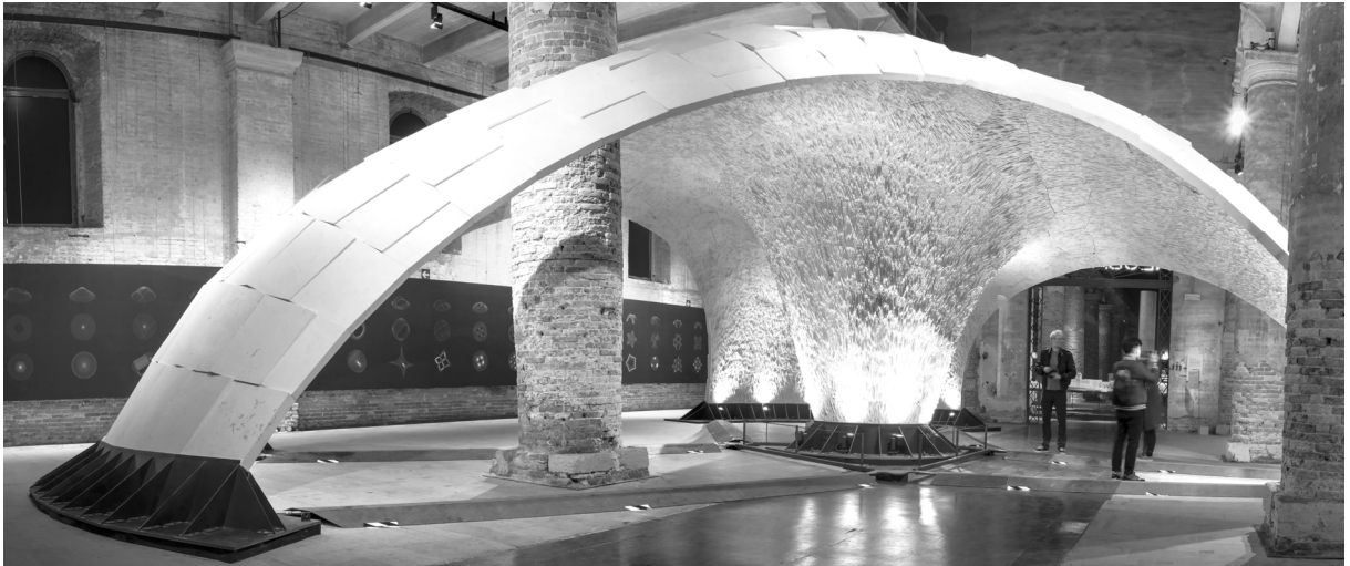
37. Armadillo Vault, boveda en piedra construida por el Block Research Group, Venezia, 2016 37. Armadillo Vault, volta in pietra costruita dal Block Research Group, Venezia, 2016
