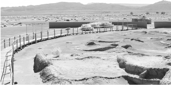
5. Particular de la pasarela que sigue el perfil del muro que rodea la aldea 5. Particolare della passerella che segue il profilo del muro che circonda il villaggio
