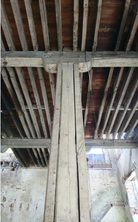
Estructura interior molino: pilar, viga, envigado. 2018.
