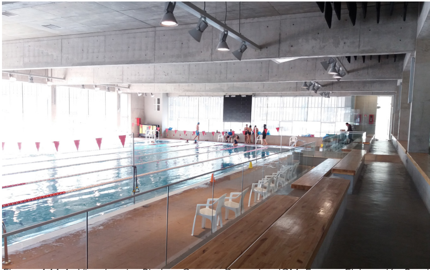
Figura 4.14 A Vista Interior Piscina Campus Deportivo JGM. Fuente: Elaboración Propia Fecha: Junio/2018
