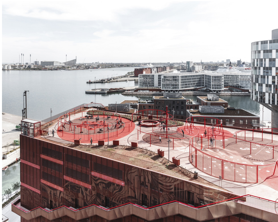
Figura 4.15 Vista Aérea Park 'n' Play Fuente: Arch Daily
