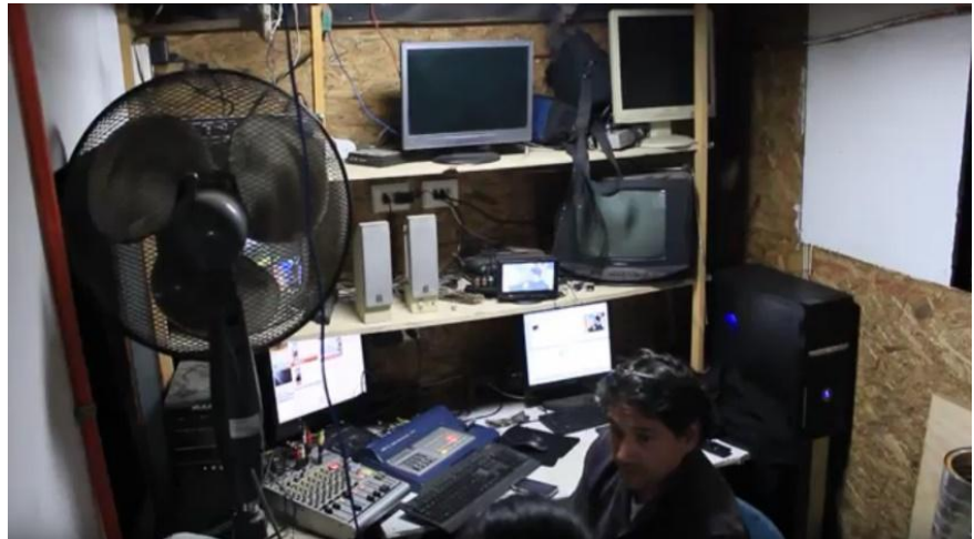
Segundo piso Canal 8, el “switch”. Carlos León frente a los controles.
