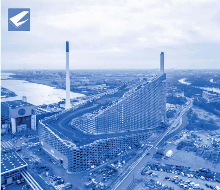
Fig. 6 ARC en etapas finales de construcción_Big.dk,2019
