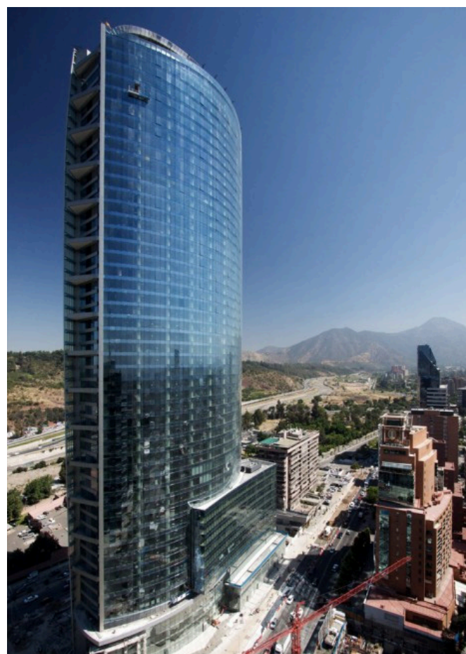
FIG. 79. Edificio de oficinas Torre Titanium. Fuente de: plataformaarquitectura.cl
