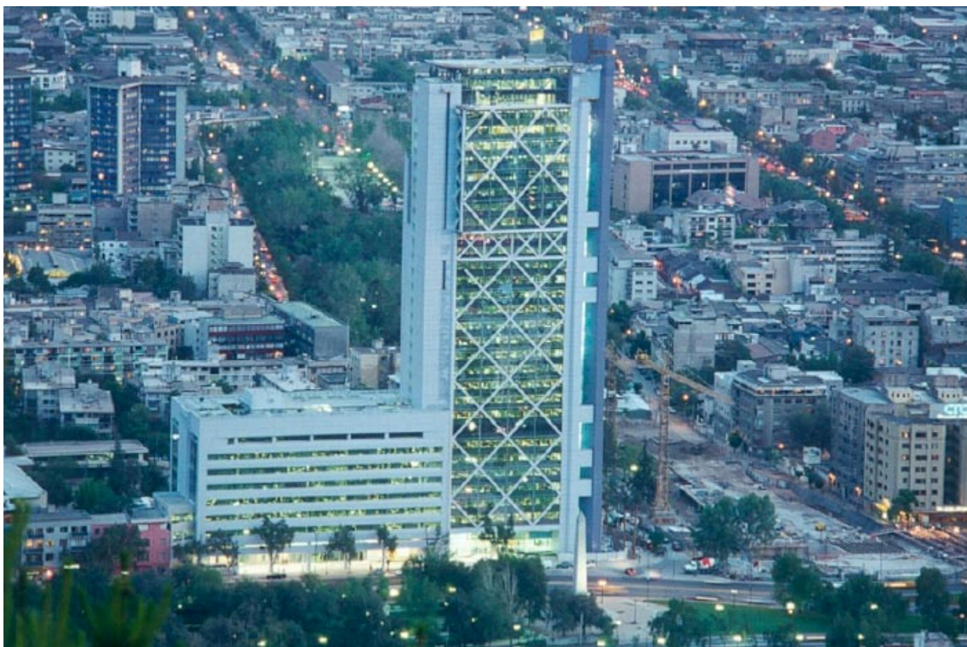
FIG. 130. Fotografía aérea del edificio. Fuente de: lcvarquitectura.com .
