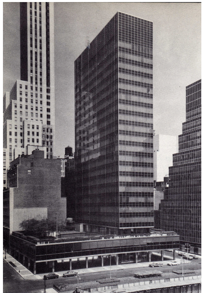
FIG.5. Lever house (1950-52), ejemplo de edificio corporativo. Fuente de: http://www.diedrica.com/search/label/Movimiento%20moderno
