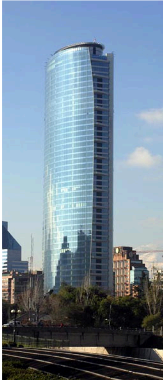
FIG. 155. Fotografía del edificio. Fuente de: arquitecturaenacero.cl .
