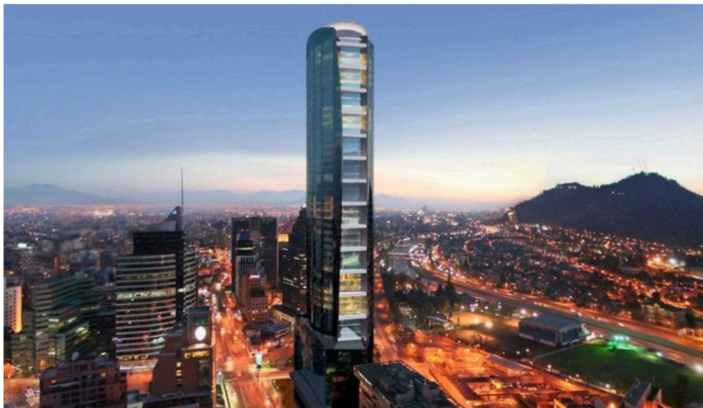
FIG. 135. Fotografía del edificio. Fuente de: flickr.com
