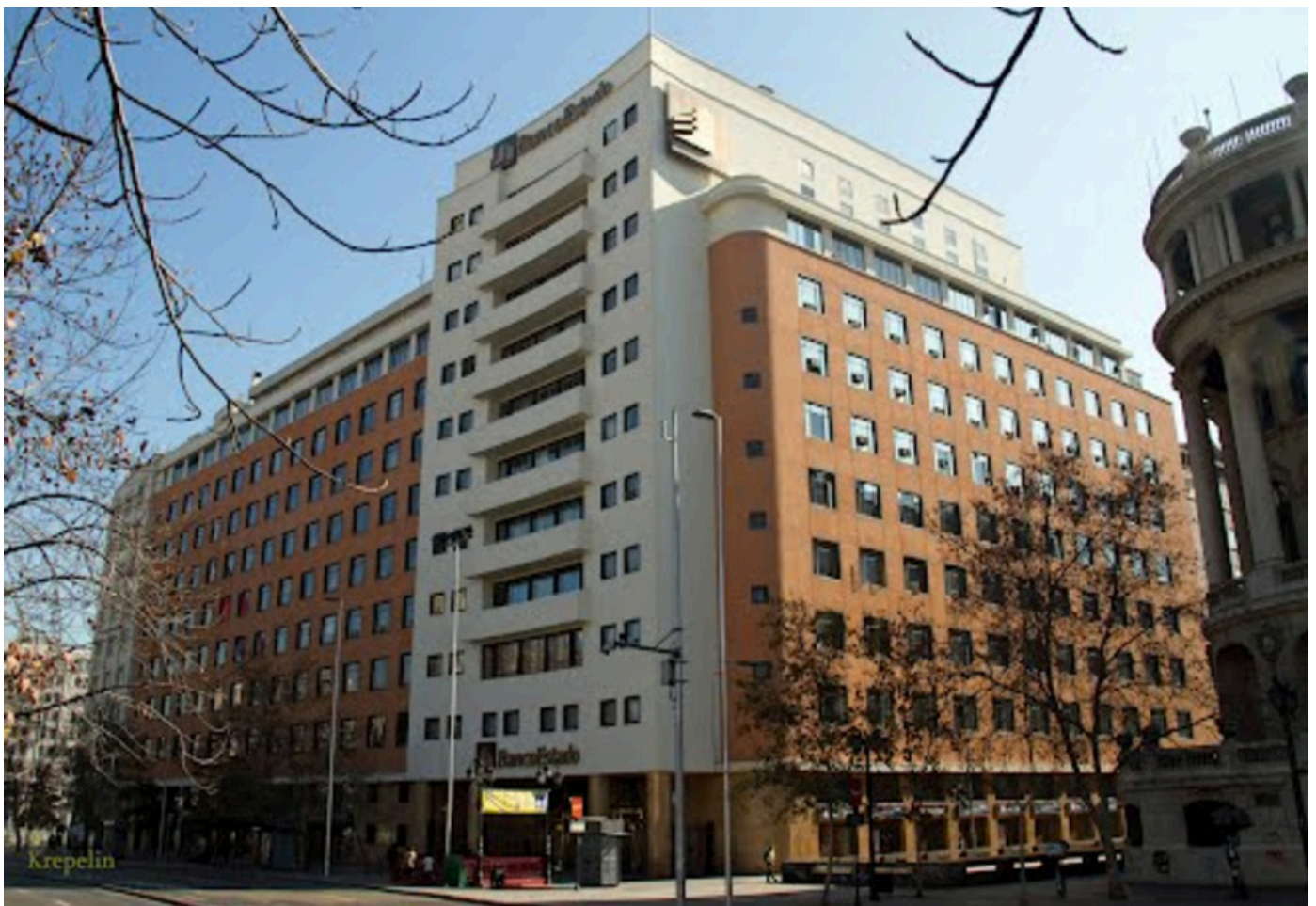
FIG. 77. Ex edificio Caja Nacional de Ahorro, actual Banco Estado. Fuente de: Colegiodearquitectos.com
