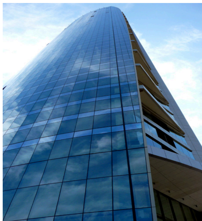
FIG. 142. Fotografía del edificio. Fuente de: arquitecturaenacero.cl .
