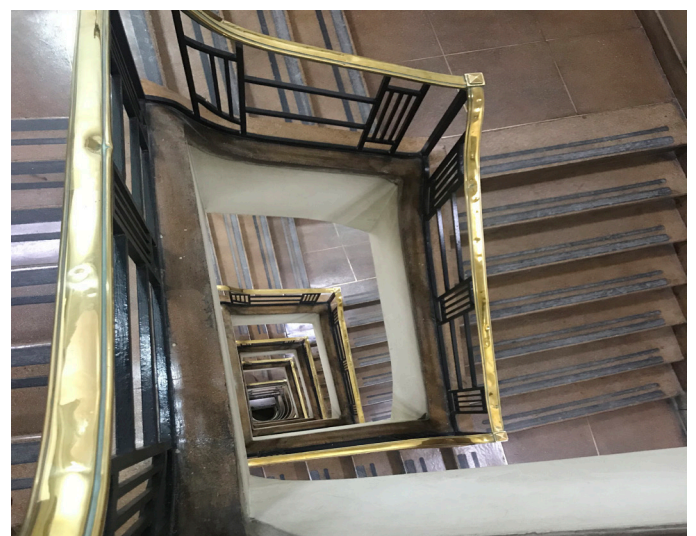
FIG. 99. Imágen de caja de escaleras secundarias. Fuente de: Fotografía del autor.
