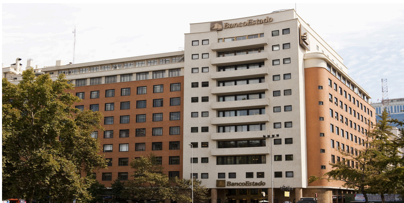
FIG. 91. Fotografía frontis principal del edificio. Fuente de: fen.uahurtado.cl.
