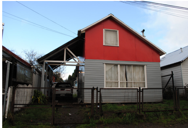
Figura 74: Viviendas “Tipo A” con bajo nivel de transformación. Modificaciones de ventanas y puertas interiores y exteriores; cambios de materialidad y color exterior; instalación de rejas y portones; implementación de techumbres para proteger de la lluvia el acceso a la vivienda. Fuente: elaboración propia, 2018.
