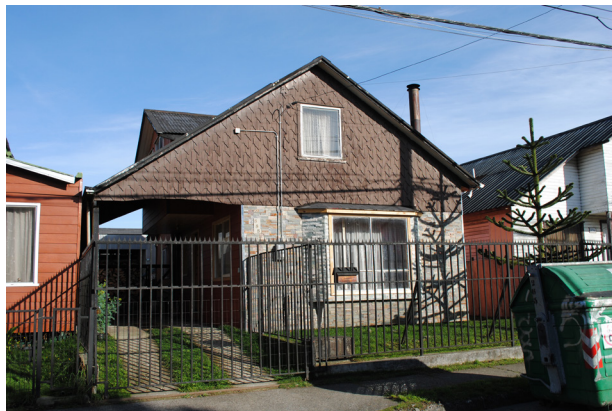
Figura 96: Vivienda de Mireya. Fachada norte y fachada nor-poniente. Fuente: elaboración propia, 2019.
