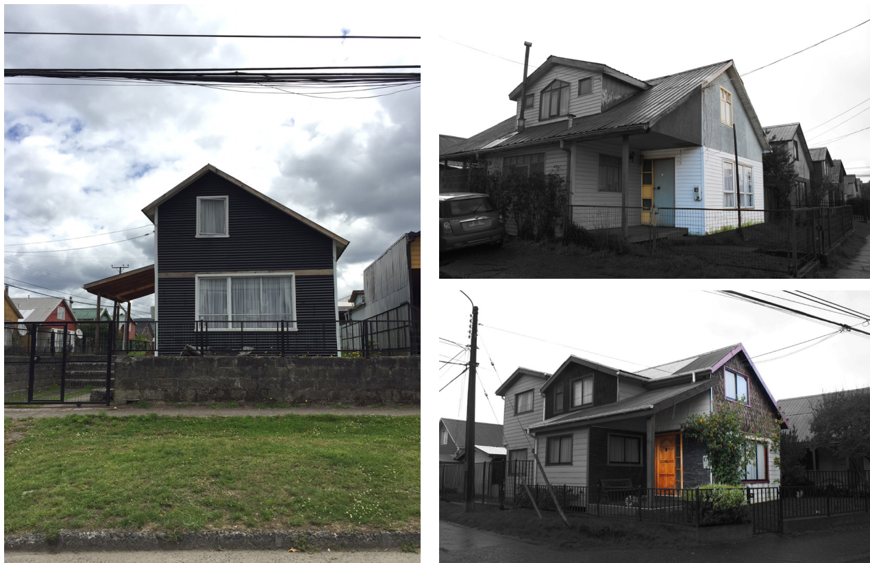
Figura 70: Ejemplos de viviendas con alto y bajo grado de transformación. Izquierda, vivienda con bajo grado de transformación: se remodela la vivienda cambiando la materialidad exterior y cambiando marcos de ventanas. Derecha, viviendas con alto grado de transformación: se ven a simple vista más de una ampliación, sin embargo se sigue reconociendo la fachada principal de la vivienda original y la conservación de las ventanas de la misma. Fuente: elaboración propia, 2018.
