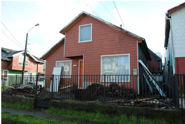
Figura 75: Viviendas “Tipo B” con bajo nivel de transformación. Modificaciones de ventanas y puertas interiores y exteriores; cambios de materialidad y color exterior; instalación de rejas y portones; implementación de techumbres para proteger de la lluvia el acceso a la vivienda. Fuente: elaboración propia, 2018.
