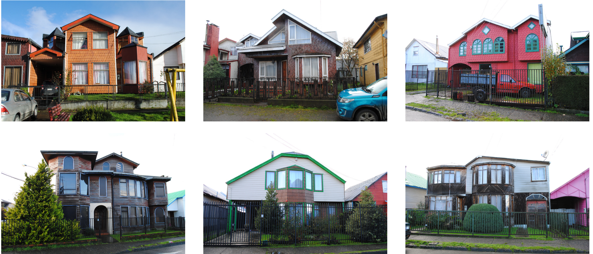
Figura 62: Viviendas con alto grado de transformación pero en las que no se reconocen elementos de la vivienda original, a diferencia de las viviendas de la Figura 58. Se reconocen grandes volúmenes y más de una ampliación tanto en densificación horizontal como vertical. Se advierten cambios de color y materialidad exterior. Se implementa un gran número de ventanas, de variados materiales y formas. En este caso existe la posibilidad de que hayan sido demolidas y construidas nuevamente. Fuente: elaboración propia, 2018.
