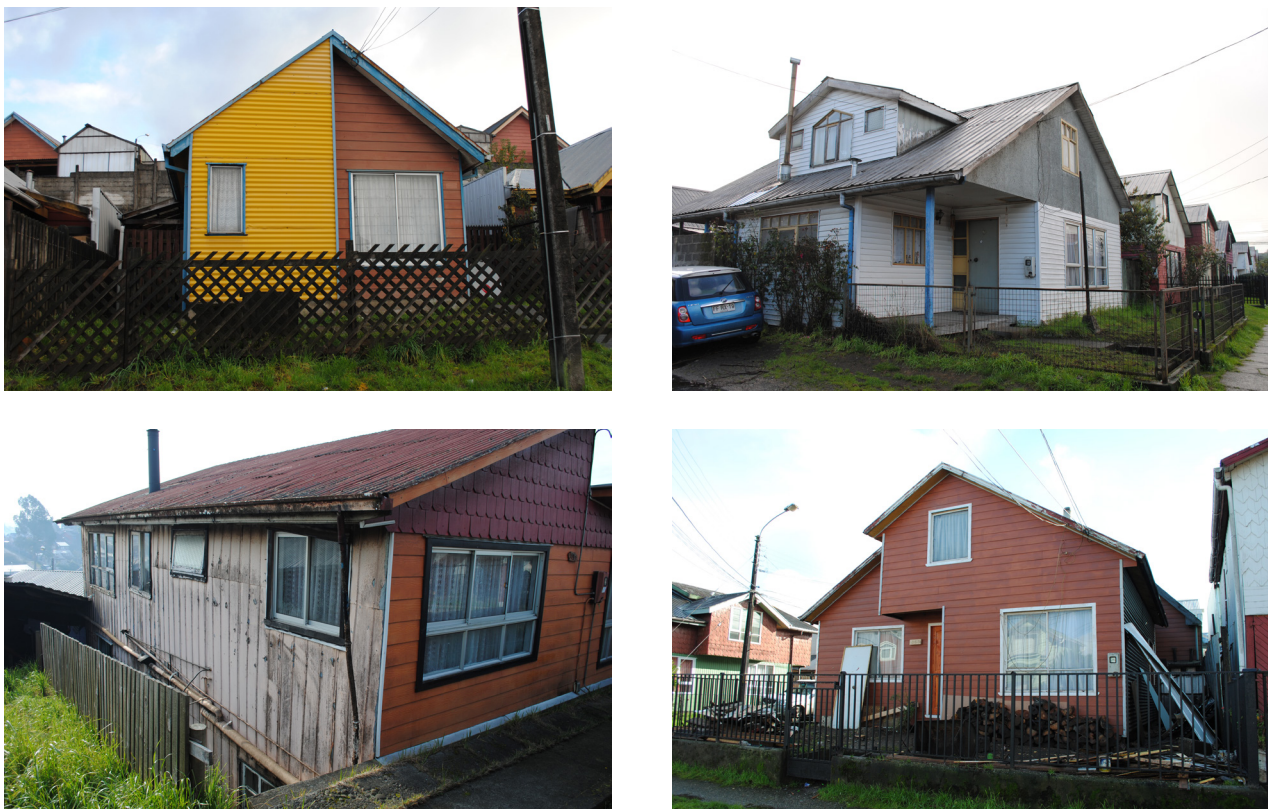
Figura 31: Materialidad de viviendas sociales en Castro. Arriba izquierda: zinc y tablas de fibrocemento 10 , Altos de Chiloé. Arriba derecha: hormigón, zinc y fibrocemento, Villa Guarello. Abajo izquierda: madera, tablas y tejas de fibrocemento, Rene Schneider. Abajo derecha: revestimiento completo de fibrocemento y ventanas de PVC, Villa Guarello. Fuente: Elaboración propia, 2018. • El Patio:
