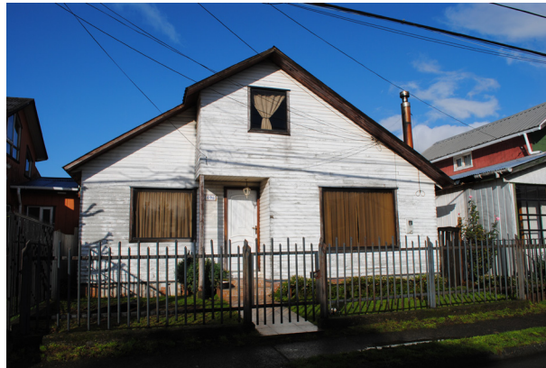
Figura 75: Viviendas “Tipo B” con bajo nivel de transformación. Modificaciones de ventanas y puertas interiores y exteriores; cambios de materialidad y color exterior; instalación de rejas y portones; implementación de techumbres para proteger de la lluvia el acceso a la vivienda. Fuente: elaboración propia, 2018.
