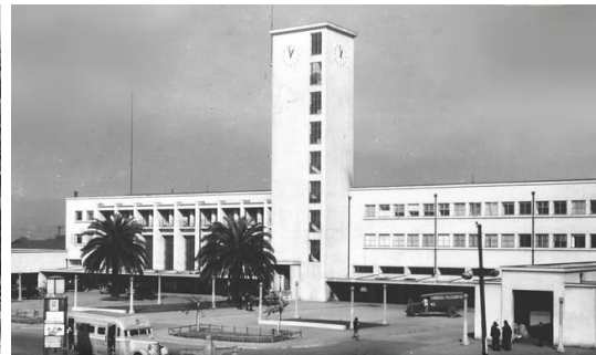
Figura 8: Estación de trenes Concepción
