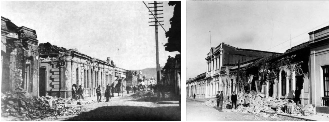
Figura 4 y 5: Talca tras el terremoto de 1928 Fuente: Emol
