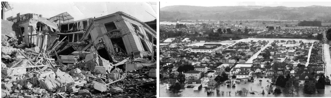
Figura 9 y 10: Valdivia tras el terremoto de 1960 Fuente: Biobío.cl
