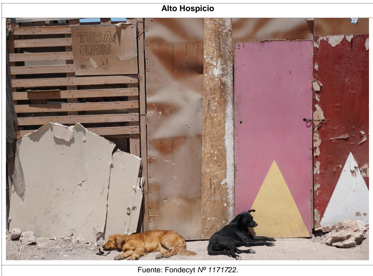
Figura N° 40. Fotografía de fachada
