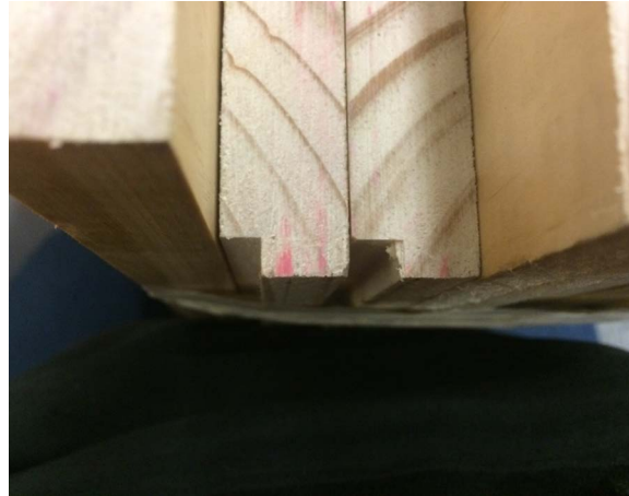
Fig. 172 —Detalle de terminaciones. Calado para vidrios
