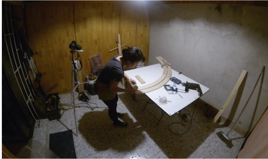
A. Construcción de arco
