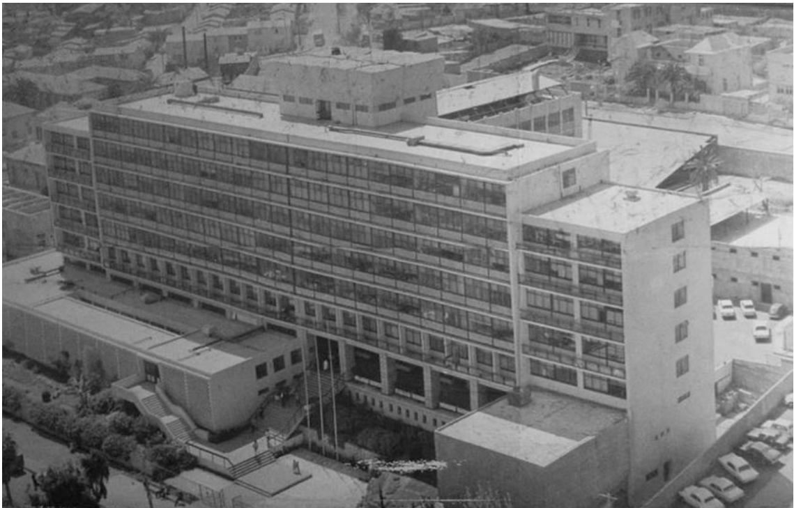
Imagen 12 Vista general del Hospital Regional de Antofagasta, en http://www.hospitecna.com/Tipologia-Hospitales-Generales/Articulos/arquitectura-estatal-los-hospitales/id-Lbidfjhbjfeggje.xsql
