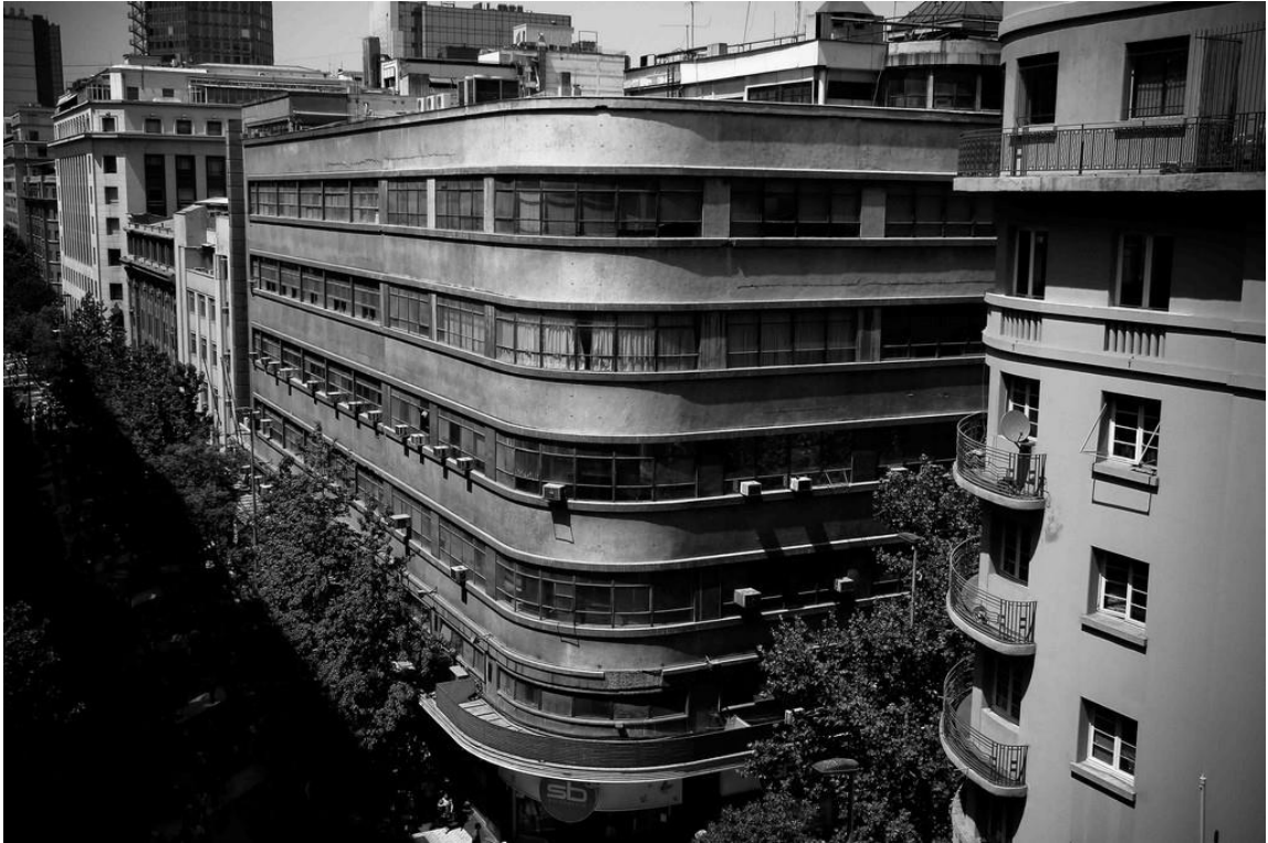
Imagen 43 Vista general del edificio Oberpauer del arquitecto Sergio Larraín García, en: http://www.plataformaarquitectura.cl/cl/02-235555/clasicos-de-arquitectura-edificio-oberpauer/51192e27b3fc4b07b9000010-clasicos-de-arquitectura-edificio-oberpauer-foto
