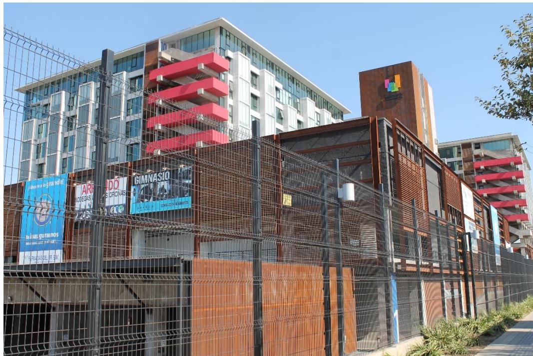
Imagen 57 Reciclaje el edificio. Vista desde la calle Manuela Errázuriz. Registro personal, marzo, 2017
