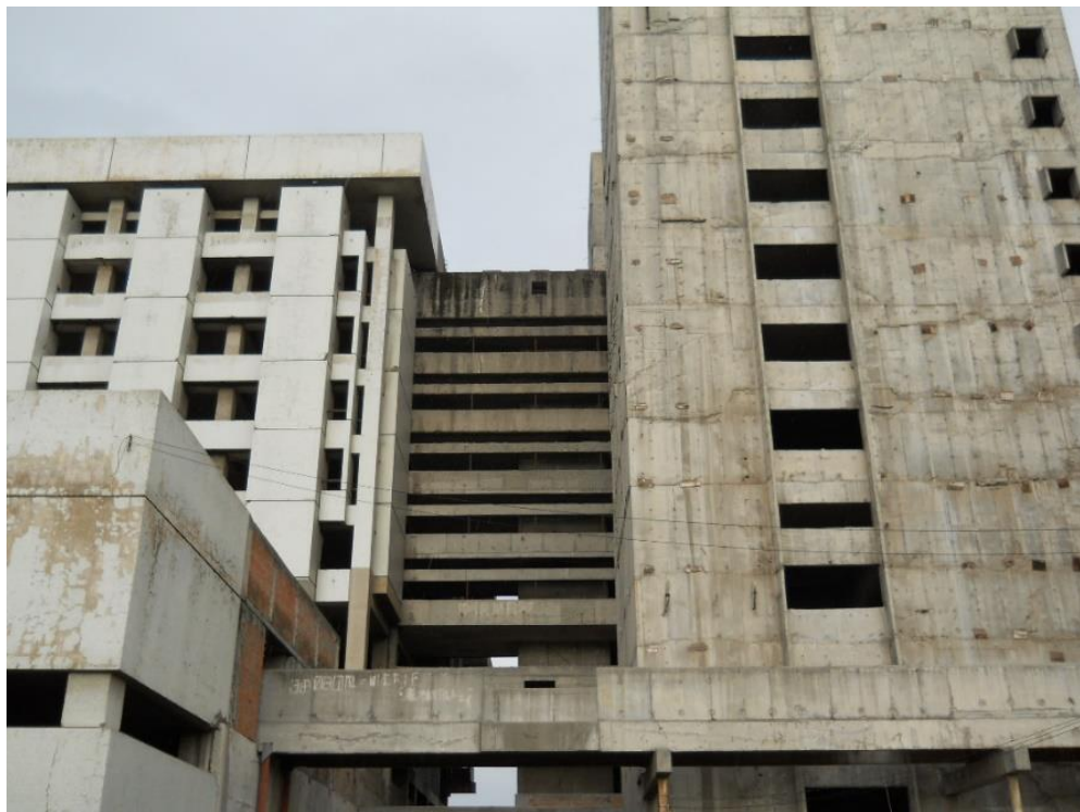
Imagen 31 Hospital abandonado, contraste entre zonas con mosaicos y zonas en hormigón a la vista. Registro personal, 2012.
