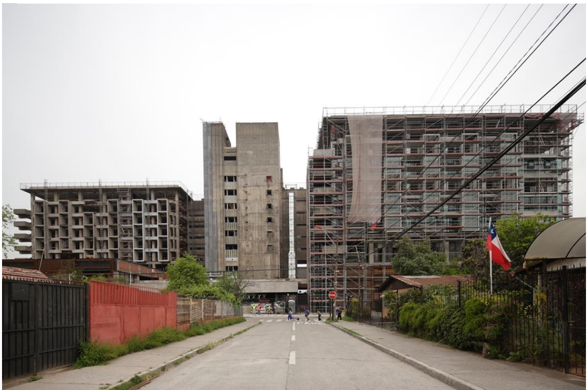
Imagen 56 Vista general. Edificio en obra durante noviembre del 2015. Fotos de Pablo Casals Aguirre, en: http://www.aboutsantiago.cl/el-elefante-blanco-resucita-despues-de-40-anos/#.WN06RPhBPY
