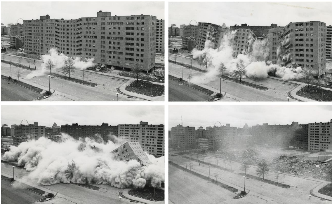
Imagen 33 Destrucción televisada del conjunto habitacional Pruitt- Igoe, en Estados Unidos. Imagen recuperada en: https://upload.wikimedia.org/wikipedia/commons/9/98/Pruitt-igoe_collapse-series.jpg
