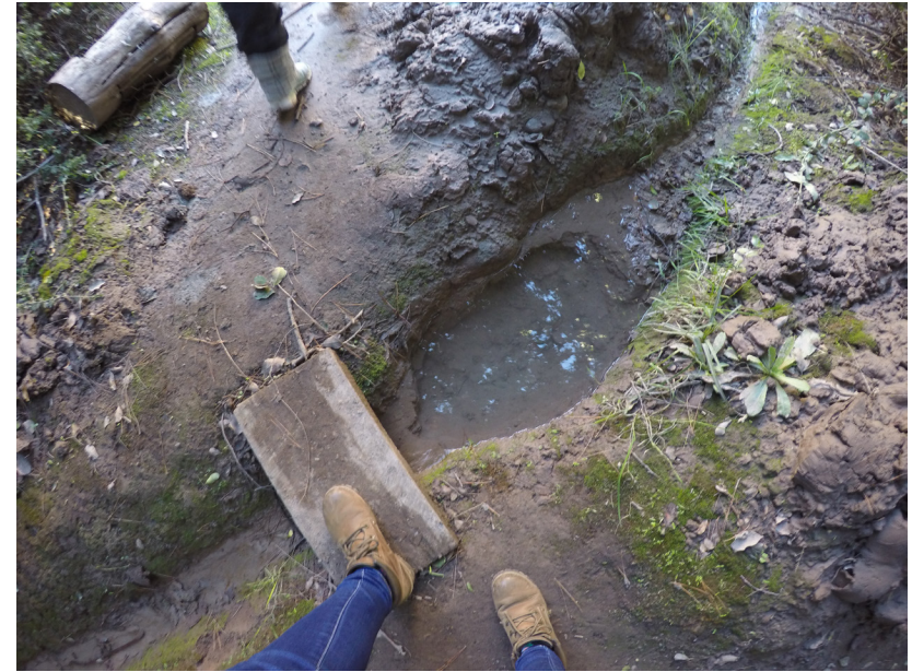
Foto 47: Paso de agua en R7. Elaboración propia.
