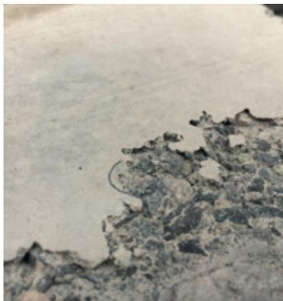
Figura 6: Palmeta de cemento chipiada con vidrio molido
