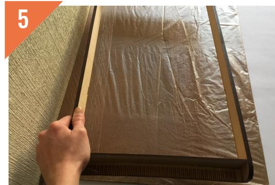
5 Una vez terminado, dejar el instrumento sobre una superficie cubierta de polietileno la cual abarque el tamaño del instrumento.
