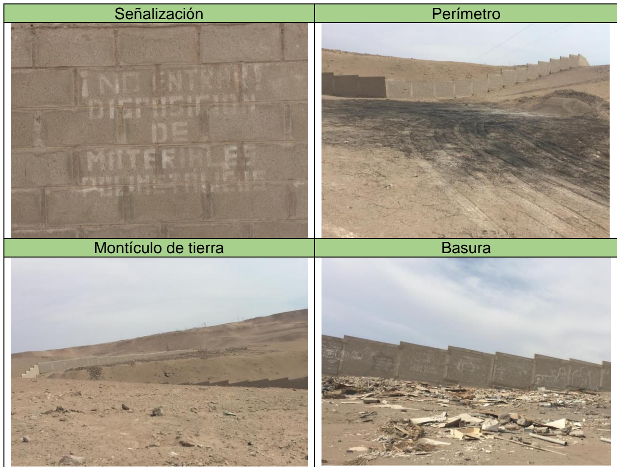
Figura 8: Estado actual de destino final de los polimetales. Fuente: Fotografías y elaboración propia, diciembre 2018
