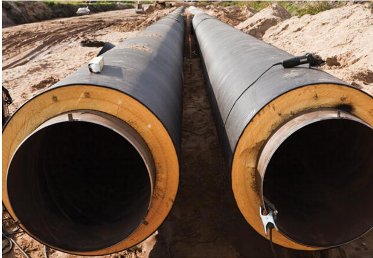
Figura 3.15: Cañerías utilizadas en sistemas de calefacción distrital. [19]
