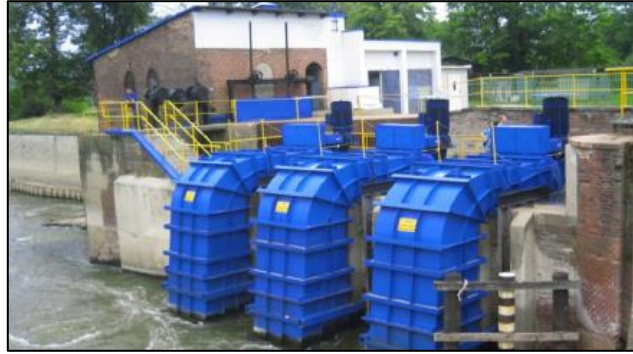
Figura 2-22: Esquema de una bomba centrífuga utilizada para la generación de energía (Adau, 2012)
