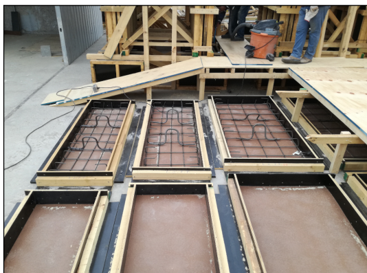
Figura 3.5. Enfierradura encofrada.
