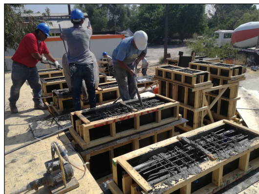
Figura 3.6. Hormigonado.
