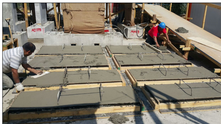
Figura 3.7. Terminación del hormigonado.
