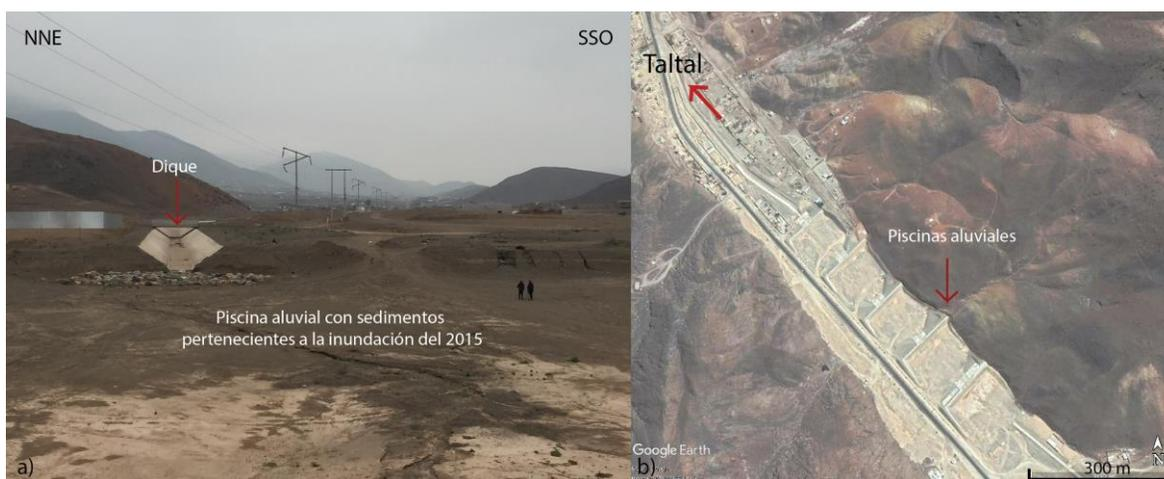
Figura 70: Piscinas aluviales construidas en Taltal. a) Fotografía tomada en terreno con vista hacia el SE, donde se puede observar un dique que encauza el flujo aluvial y lo lleva a la piscina, la que está llena de material de la inundación del 2015. b) Vista en planta de las 5 piscinas aluviales, extraída de Google Earth.
