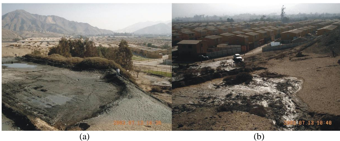
Figura 4.6. Incidente de rebalse: (a) dique de retención y cuenca del embalse de relaves de arena; (b) fallo de flujo en sentido descendente (Villavicencio et al. , 2014).
