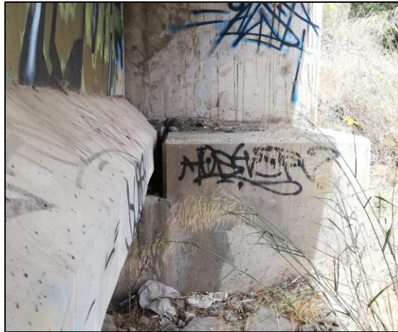
Figura 2-15: Tope sísmico en el estribo, puente Aguila Norte
