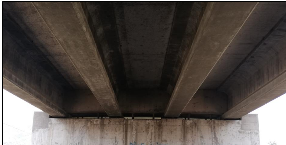
Figura 4-4: Fotografía Losa y Vigas Puente Águila Norte
