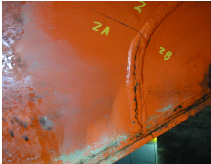
Figura 3.6: Falla en región inferior del chasis.
