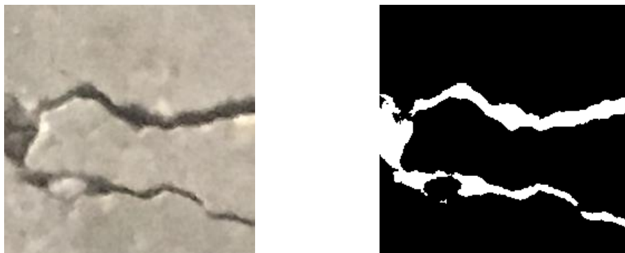
Figura 4.33: Encoder-Decoder with Skip Óptimo: Grieta real junto a grieta segmentada 6
