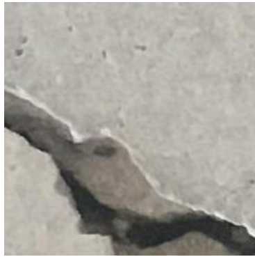
Figura 8.4: Anexo: Encoder-Decoder with Skip Óptimo: Grieta real junto a grieta segmentada
