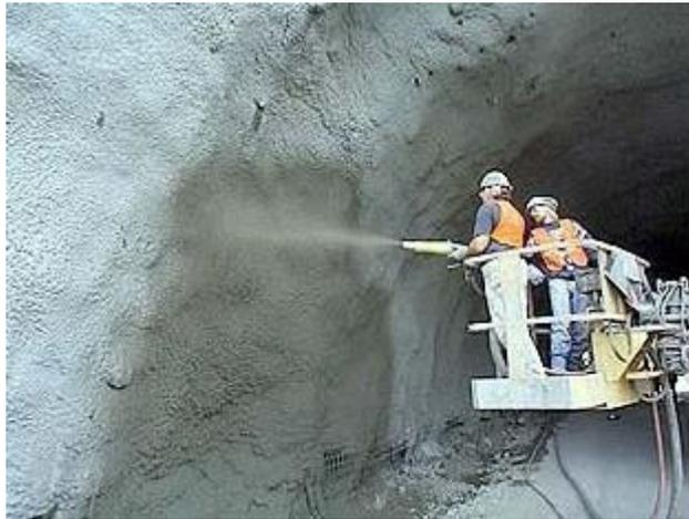
*Figura 20: Aplicación de shotcrete (Neotecnica SAC Ingeniería)*
