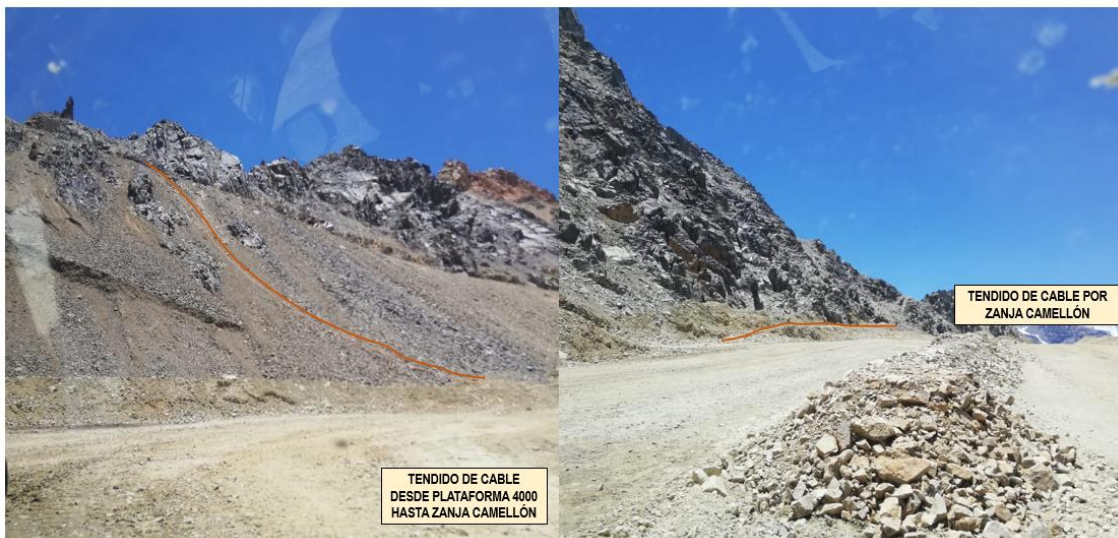
Figura 46: Tendido Eléctrico Zanja Camellón resultante de la ejecución de la actividad (6.3.3). Fuente: Captura propia.
