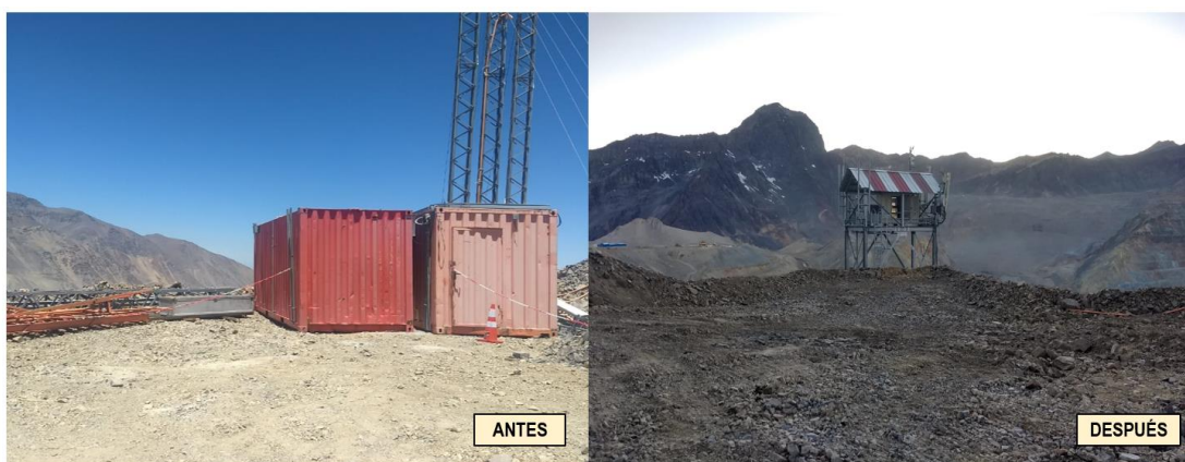
Figura 37: Desarme infraestructura plataforma 3940 ante y después. Fuente: Captura propia.
