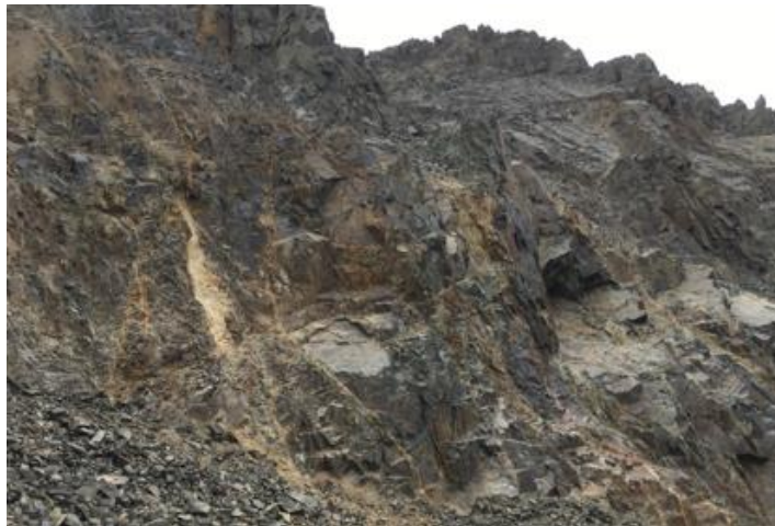
Figura 33: Resultados de ejecución de trabajos de saneamiento manual. Fuente: Captura Propia
