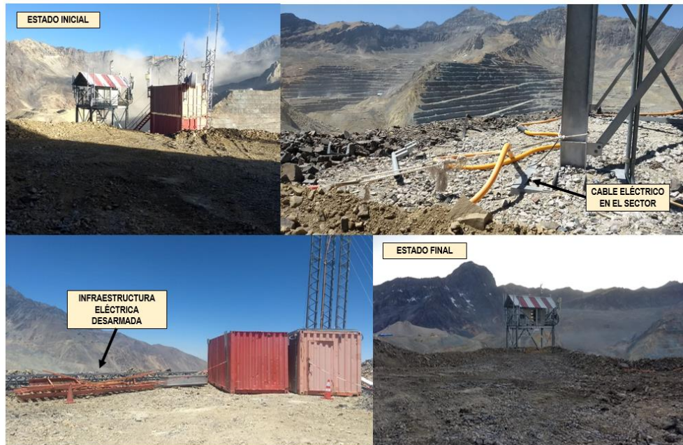
Figura 43: Desarme y retiro infraestructura eléctrica que evidencia el paso por la etapa de ejecución del trabajo. Fuente: Capturas propias.
