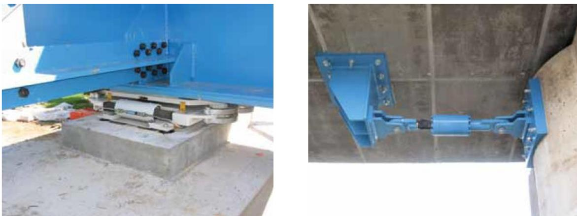
Figura 1.1. Ejemplo de Disipadores de Energía. Izq.: Amortiguador metálico instalado en apoyo de puente. Der.: Amortiguador viscoso instalado en apoyo de puente. Fuente: Protección Sísmica de Estructuras, 2012.
