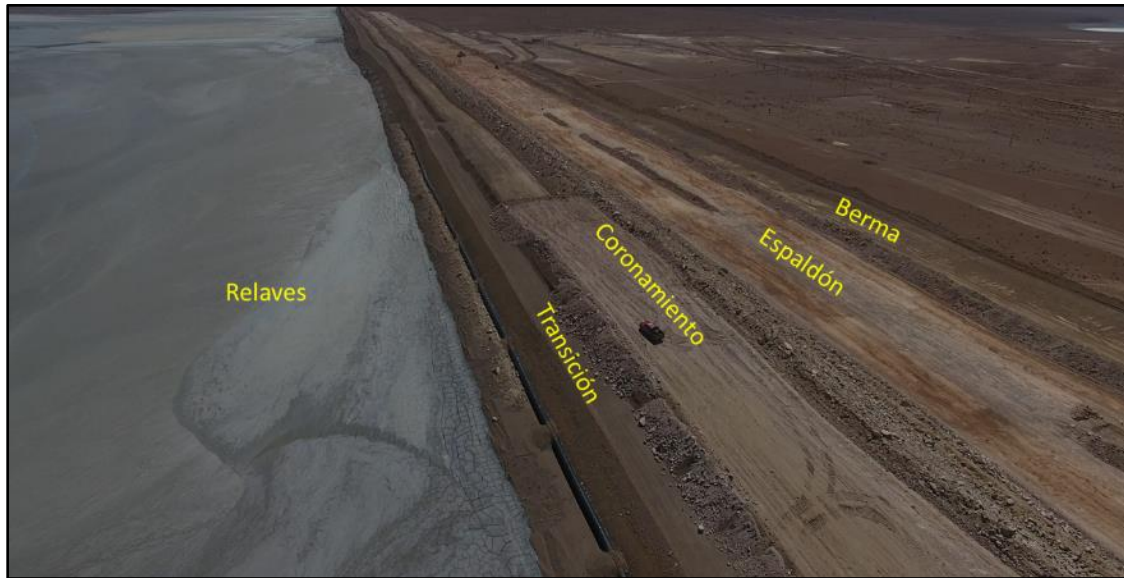
Figura 5-3 Muro del Tranque: Berma, Espaldón, Coronamiento y Transición.
