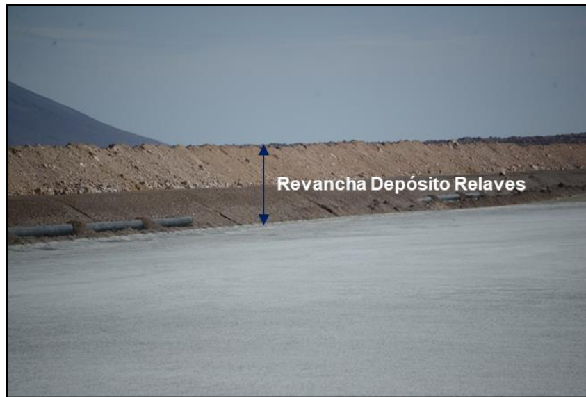
Figura 5-6 Revancha que Tiene Relave vs Altura Muro
