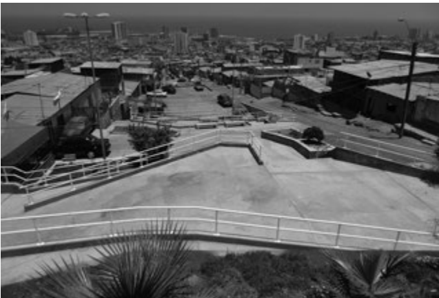
Figura 87. Intervención Quebrada Riquelme
