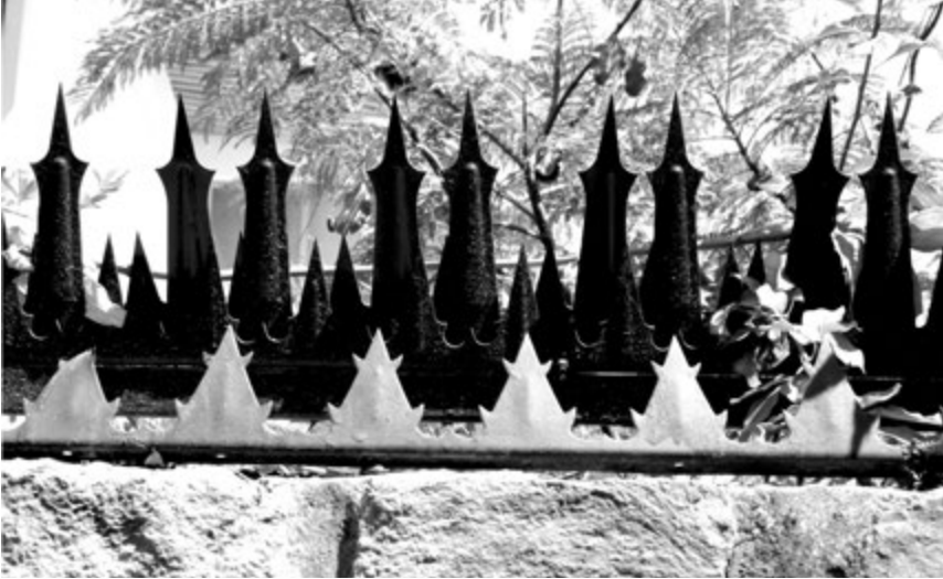
Figura 7. Adición metálica que corona un cerco exterior
