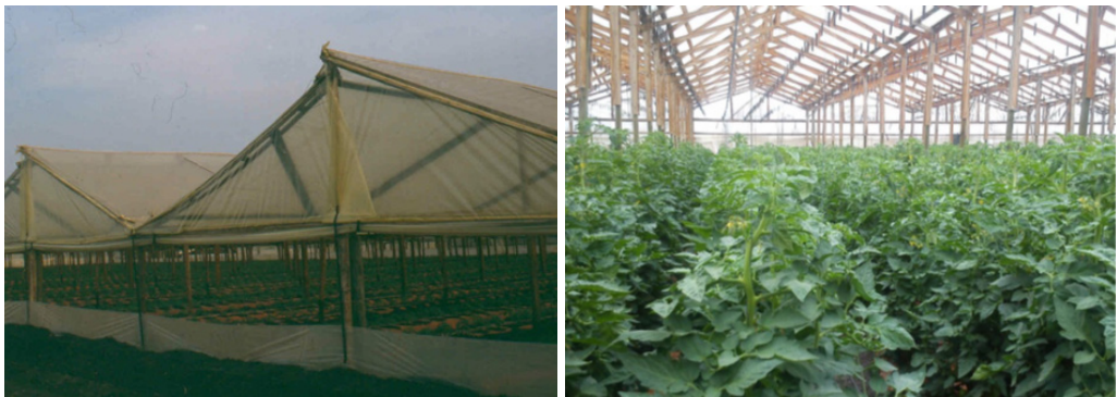
Figura 16. Exterior de invernadero tipo Capilla con producción de hortalizas en suelo en la Región de Valparaíso, Chile, con altura de 3,6 m a la cumbre (izquierda). Interior de invernadero con alzas para mejorar ventilación de cultivos de tomates en la Zona Central de Chile, con altura de 5 m a la cumbre (derecha).
